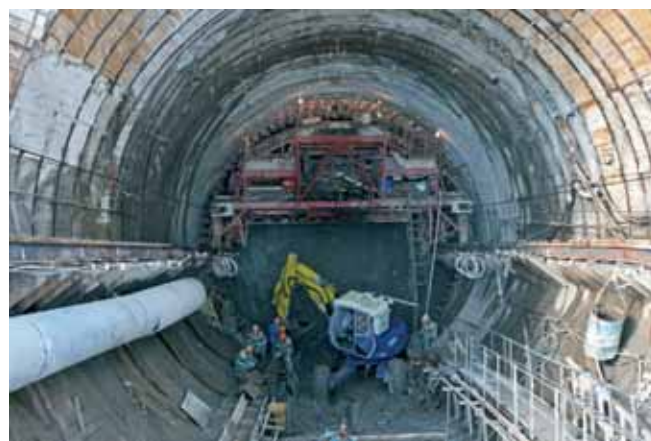
Сооружение наклонного хода станции «Звенигородская»
