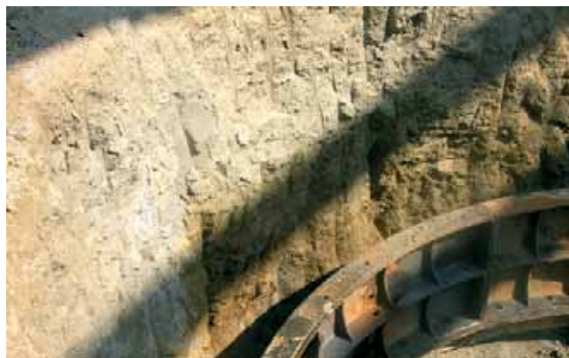
Укрепленный массив грунта внутри и вокруг зумпфа
