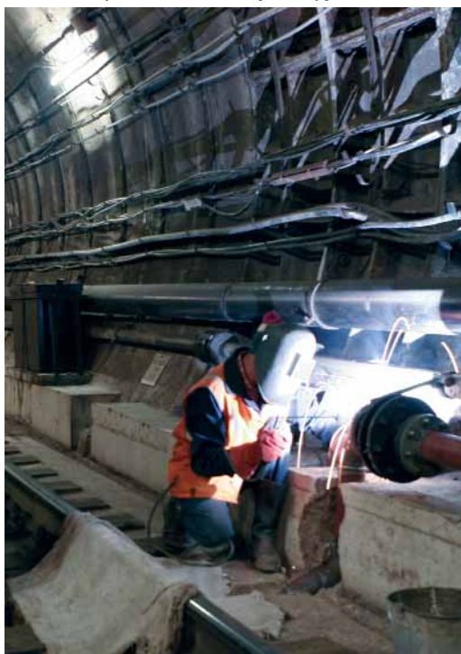
Работы в перегонном тоннеле у ст. «Трубная»
