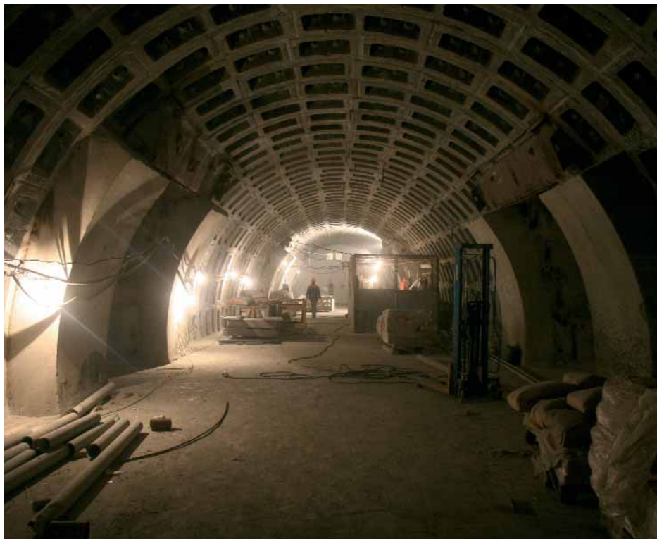
Станция «Обводный канал», сентябрь 2008 г.
