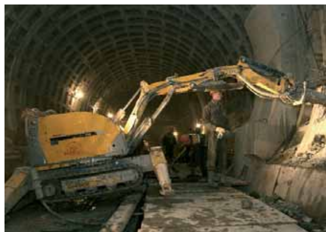
Сооружение наклонного хода станции «Звенигородская»
