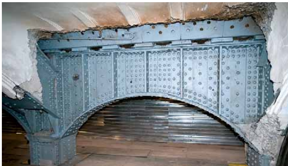
Фрагмент отреставрированной металлической обделки станции до последующего ее закрытия бетоном
