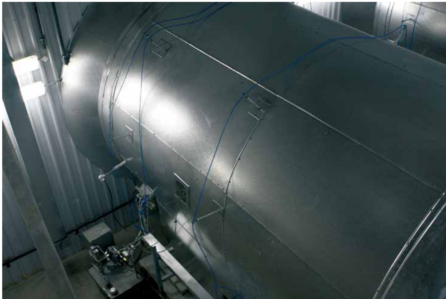
Вентилятор марки «ТАФ» немецкой фирмы «TLT-TURBO GmbH» на Серебрянборских тоннелях
