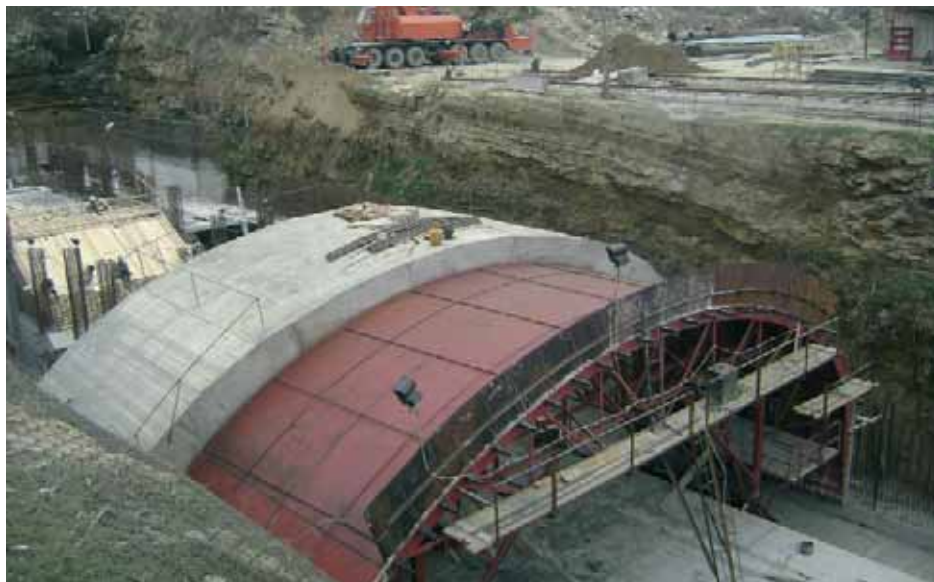
Использование передвижной опалубки на строительстве ст. «Азадлыг проспекти»
