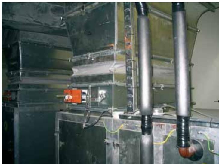
Станция метро «Строгино». Вентиляционная камера. Подключение трубопроводов теплоснабжения к приточной установке
