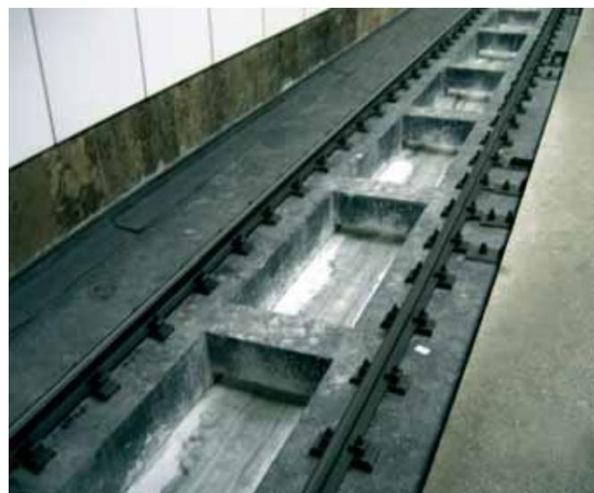
Конструкция верхнего строения пути со шпалами-коротышами из композитного материала на ст. «Деловой центр»
