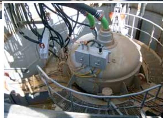
Сооружение вентиляционного ствола методом задавливания крепи
