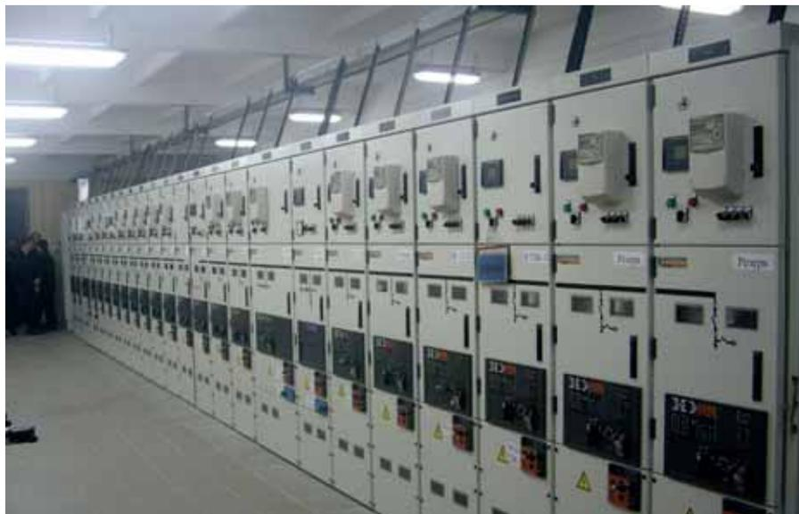
Распределительное устройство (10 кВ) с элегазовыми выключателями
