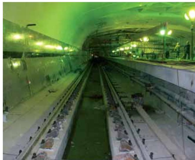
Конструкция верхнего строения пути с виброзащитным скреплением ВГС-65 на ст. «Строгино»
