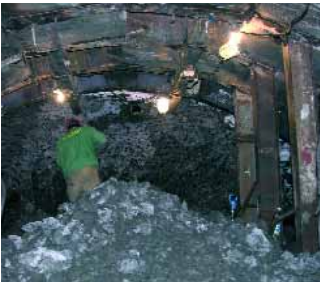
Рис. 4. Проходка в замороженном грунте
