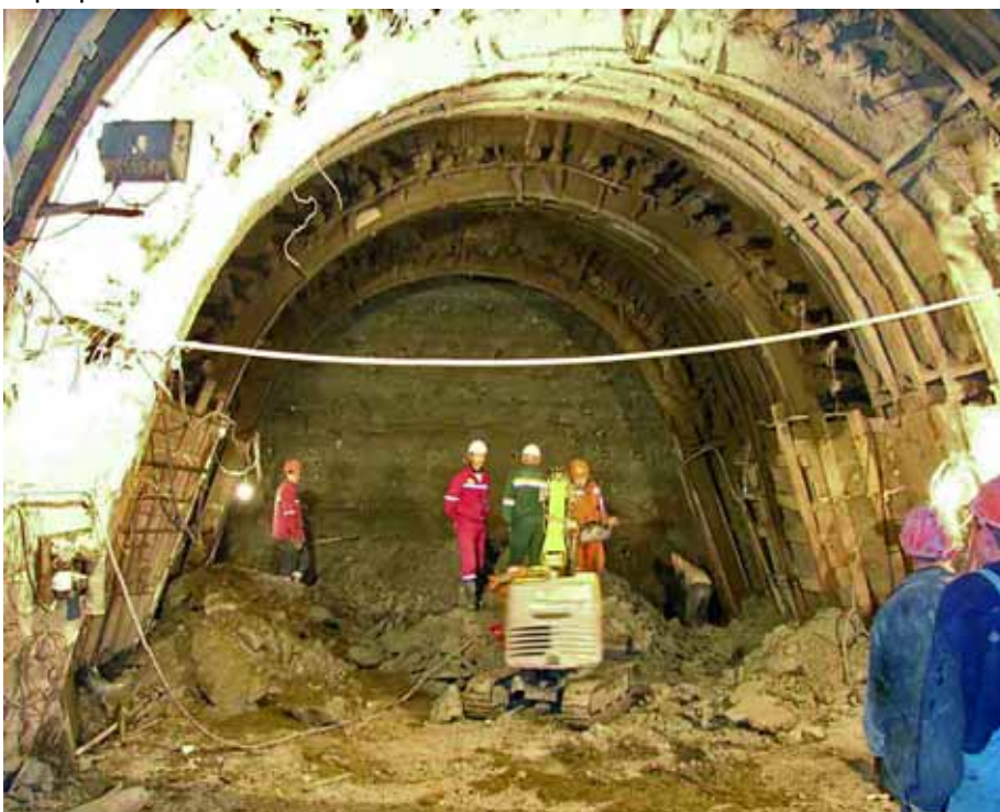
Рис. 6. Проходка подходной выработки с опережающей крепью кровли и лба забоя в протерозойских глинах
