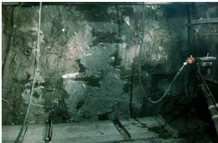
Рис. 6. Качество укрепления грунта по сбойке № 3
