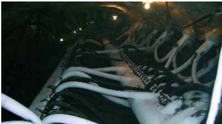
Рис. 6. Замораживание грунтов из сервисного тоннеля
