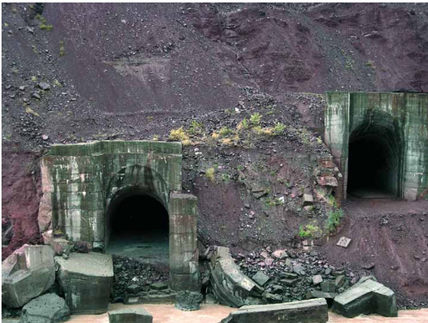
Входные порталы строительных тоннелей
