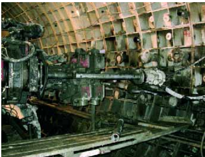
Рис. 4. Укрепление грунтов по сбойкам из сервисного тоннеля
