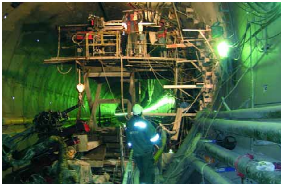
Рис. 1. Расположение инъекционного оборудования на технологической платформе в ПТТ
