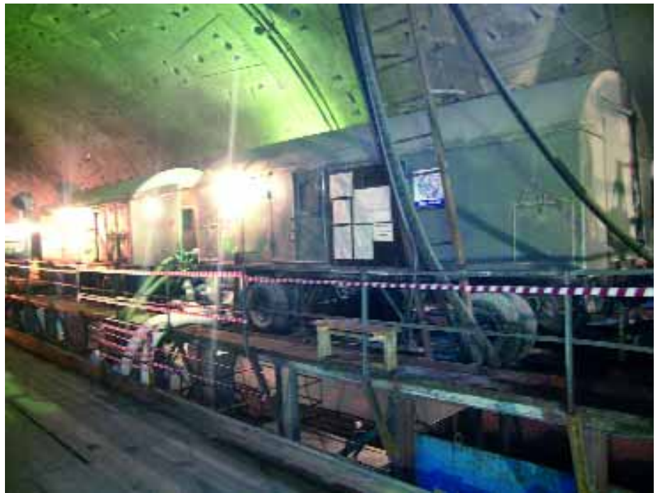
Рис. 7. Замораживающая станция в тоннеле
