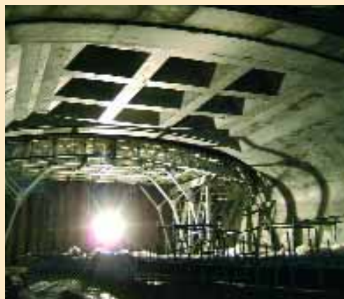
Бетонирование свода ст. «Библиотека им. А. С. Пушкина»
