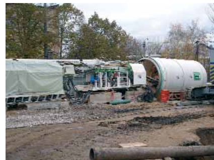
Контрольная сборка ТПМК «Херренкнехт»
