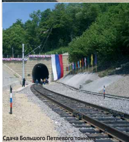
Сдача Большого Петлевого тоннеля
