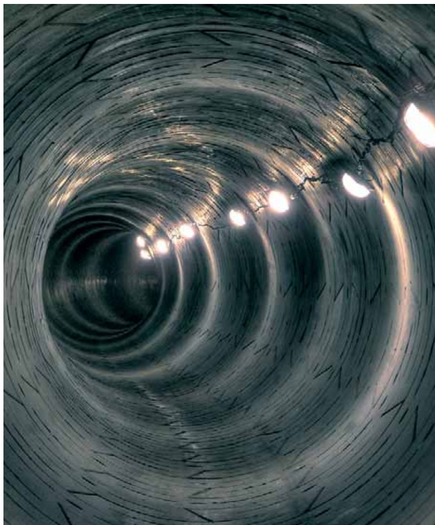
Кабельный коллектор «Угреша», пройденный с помощью ТПМК фирмы «Херренкнехт» с применением высокоточных блоков
