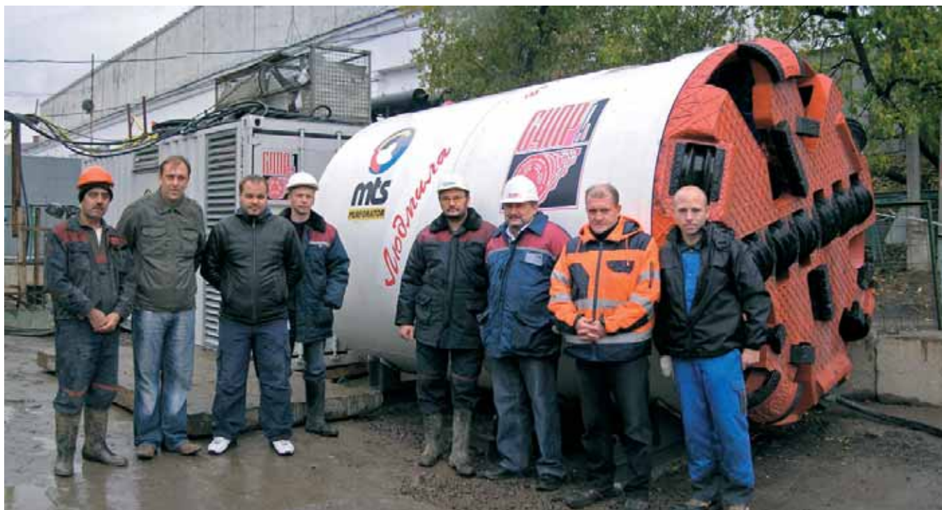
Специалисты ОАО «СУПР» на фоне микротоннельной установки фирмы «MTS Perforator»
