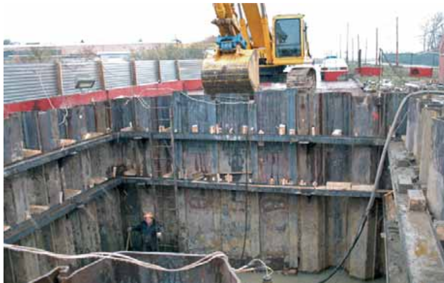
Рис. 3. Шахтный котлован, построенный с креплением из шпунта способом высокочастотного вибропогружения
