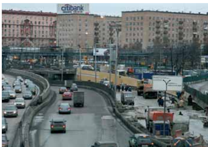
Тоннель до реконструкции
