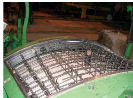
Установка полимерной футеровки и арматурного каркаса в форму для бетонирования
