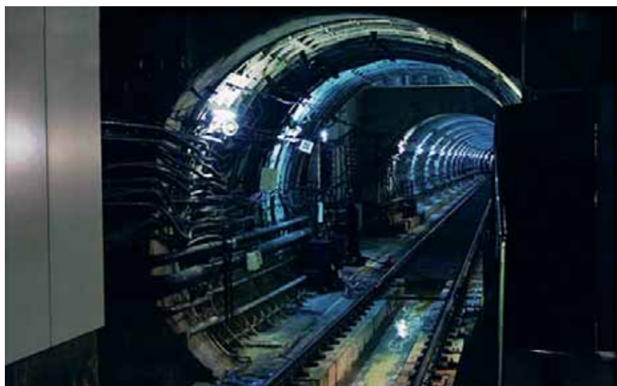
Перегонный тоннель от ст. «Киевская»
