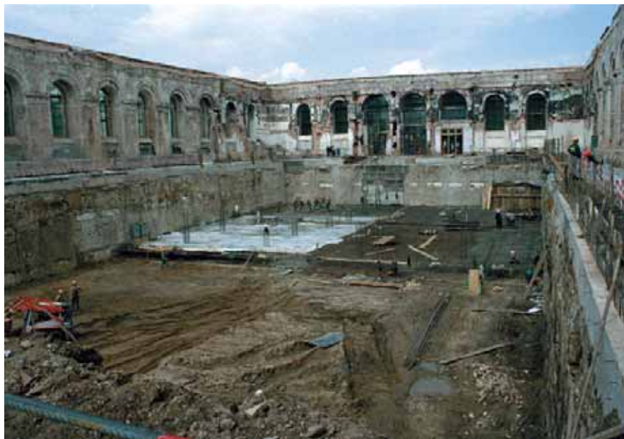
Работы по восстановлению ЦВЗ «Манеж» в Москве
