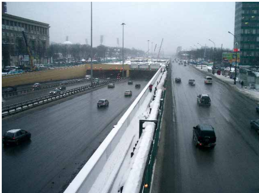
Транспортный тоннель на Ленинградском пр-те. Рамповый участок со стороны станции метро «Аэропорт»
