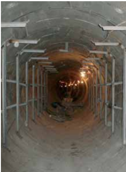
Участок готового тоннеля
