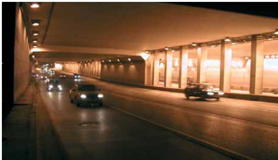
Готовый тоннель под Нахимовским проспектом в Москве
