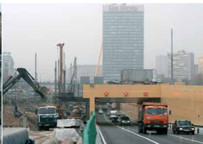
Тоннель после реконструкции
