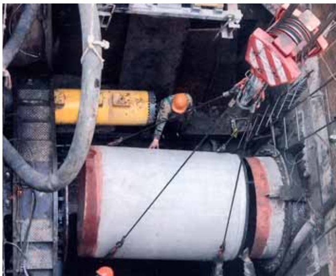
Рис. 4. Монтаж труб для задавливания через уплотнительное кольцо
