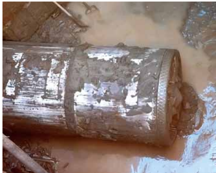
Рис. 5. Выход микрощита в приемную шахту
