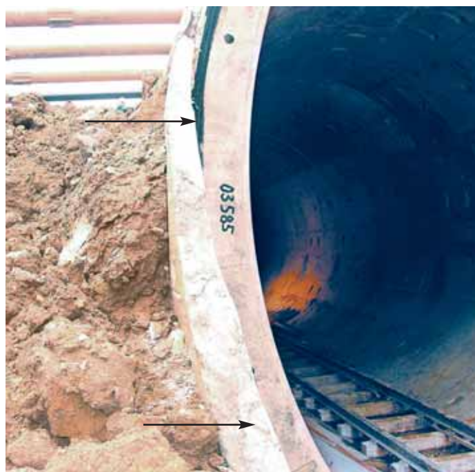
Рис. 4. Слой тампонажного камня переменной толщины по высоте обделки
