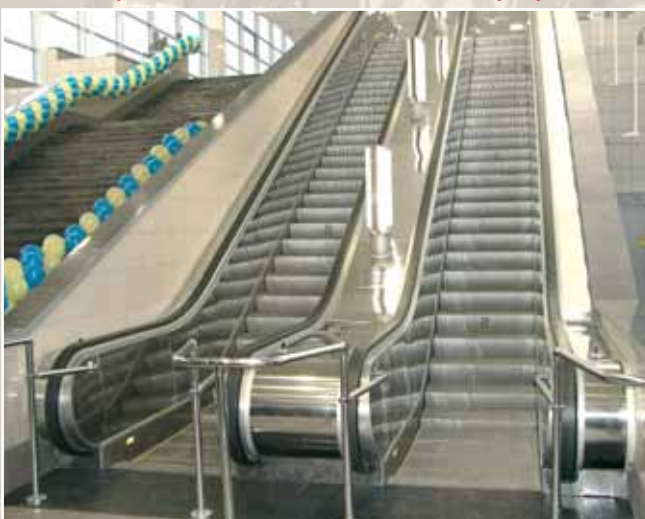
Тоннельный эскалатор ЕТК-215 (высота подъема от 3 до 15 метров)
