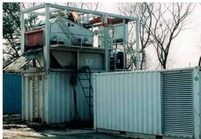
Рис. 3. Верхняя строительная площадка с сепарационной установкой, контейнером-отстойником и дизель-генератором
