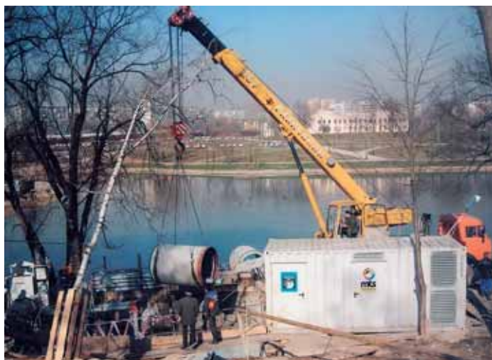
Рис. 2. Нижняя строительная площадка с проводным контейнером
