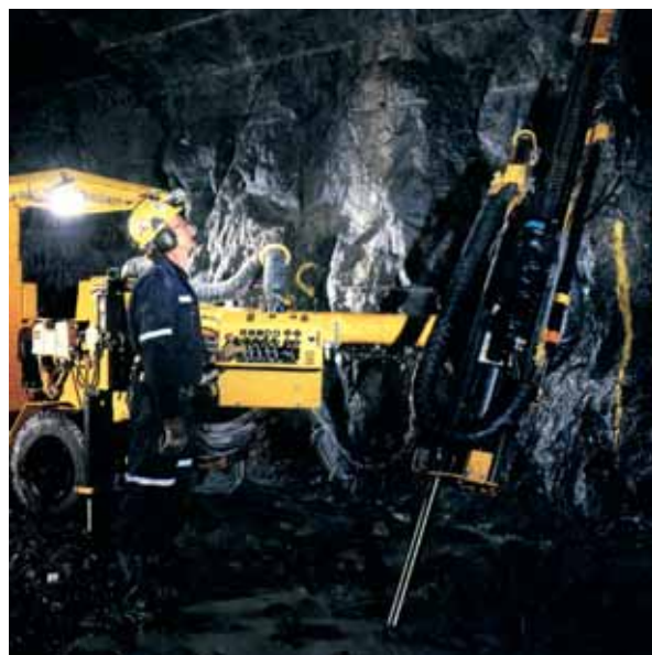
Установка анкеров для временной крепи осуществляется с помощью оборудования фирмы "Atlas Copco"
