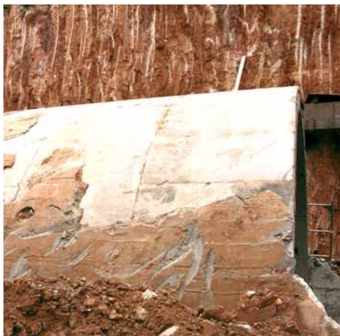
Рис. 3. Разборка тампонажного слоя экскаватором. Контакт тампонажного камня с обделкой и грунтом плотный
