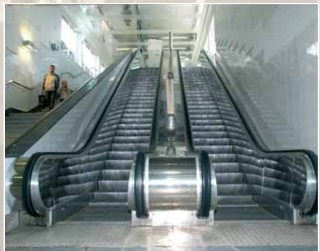
Тоннельный эскалатор ЕТК-215 (высота подъема от 3 до 15 метров)
