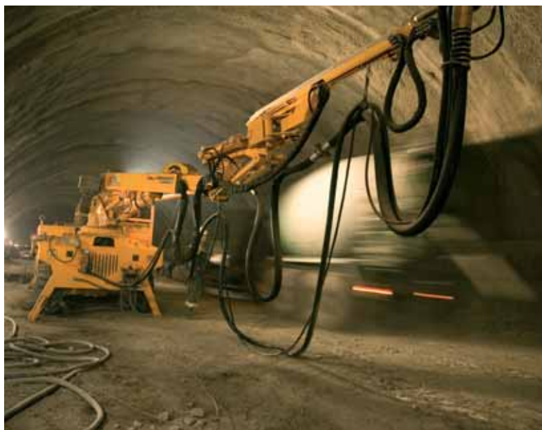
Оборудование для нанесения набрызг-бетона Sika-Putzmeister
