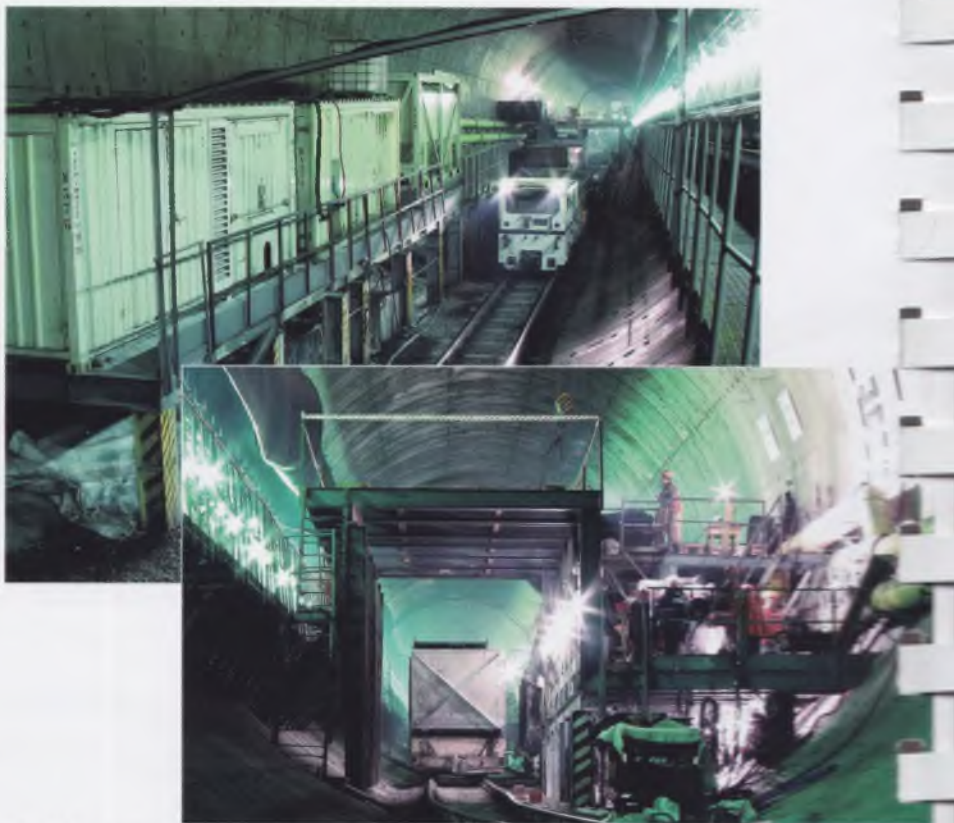
Рис. 3. Расположение технологического оборудования в транспортном тоннеле при укреплении грунта
