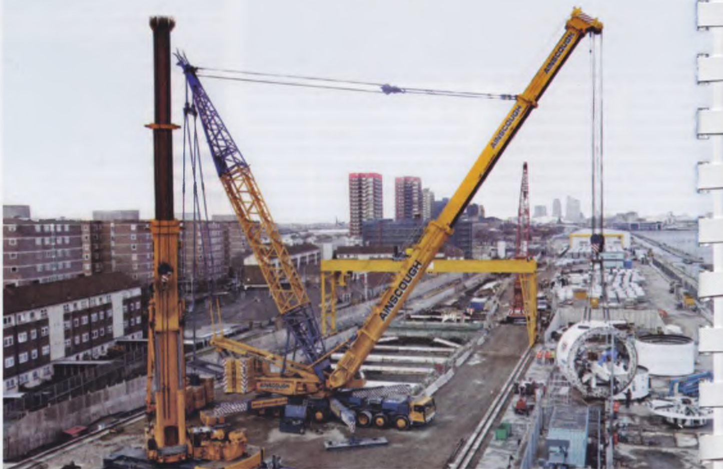
Начало строительства тоннелей для продолжения Доклендской линии ЛРТ в Лондоне
