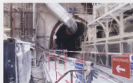
Вид на руддвор в начале проходки
