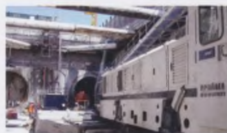
Для откатки грунта используются локомотивы «Шома»
