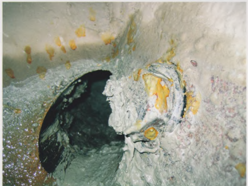
Рис. 6. Пробуренный тубинг обделки наклонного хода ст. «Достоевская»
