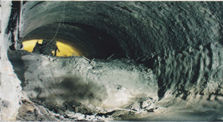
Рис. 2. Проходка основного тоннеля пролетом 12,69 м уступным способом
