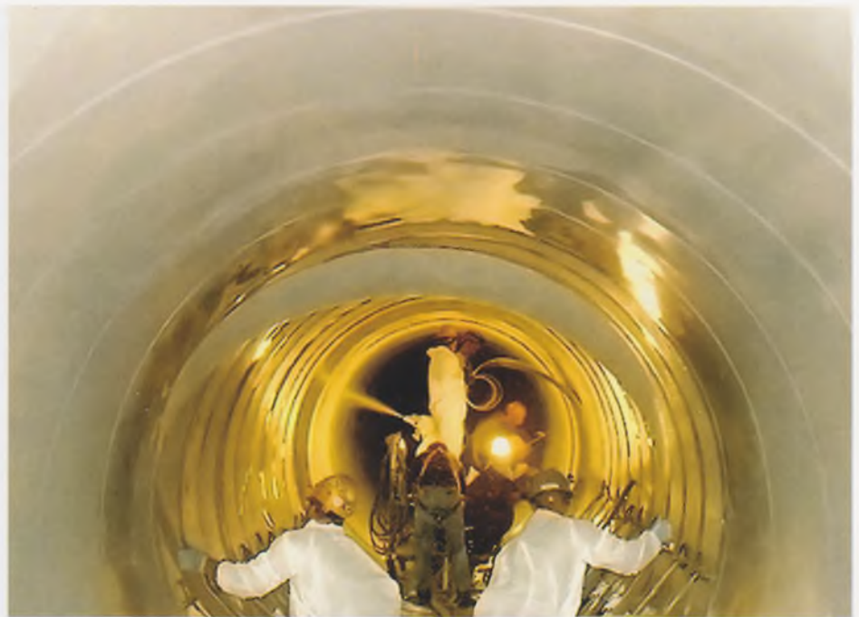
Рис. 3. Нанесение антикоррозионного покрытия Linabond Co-Lining
