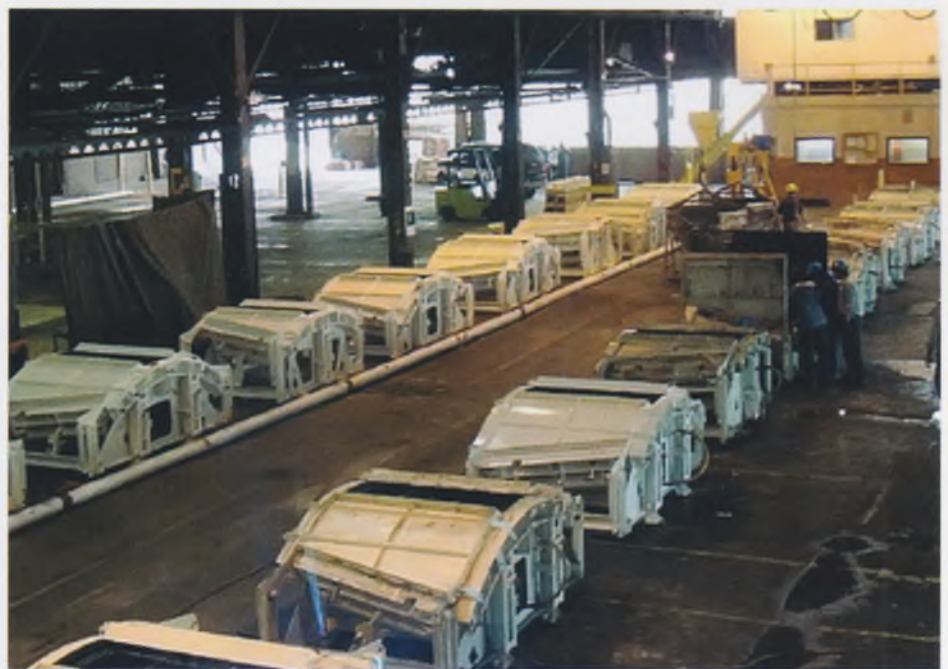
Рис. 4. Линия по изготовлению преднапряженных армированных сталефибробетонных сегментов для установки на участке 2
