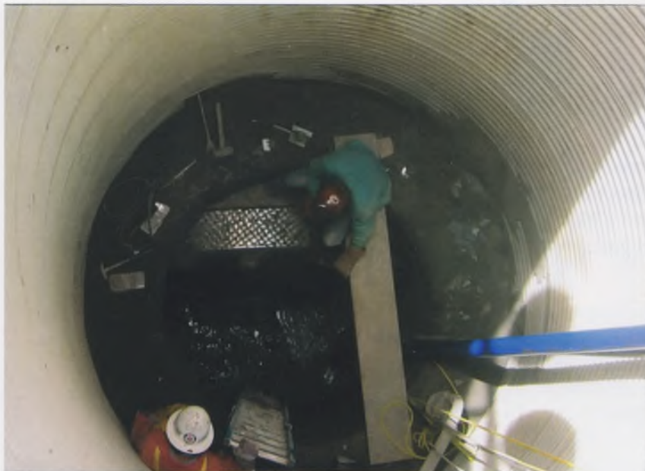
Рис. 5. Врезка в первую канализационную шахту участка 1
