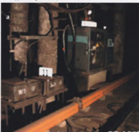
Рис. 4. Дроссель-трансформатор 825 В. Пикет: 105+26,2 м, «Проспект Ветеранов» – «Девяткино»:
