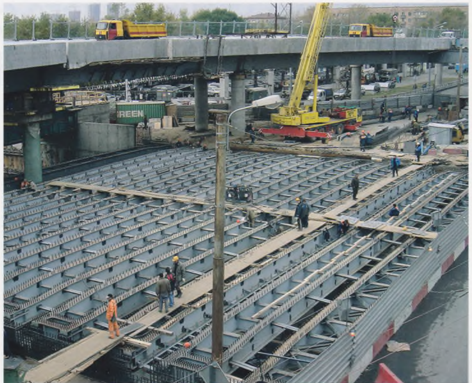
Рис. 7. Сооружение нового металлического перекрытия тоннеля
