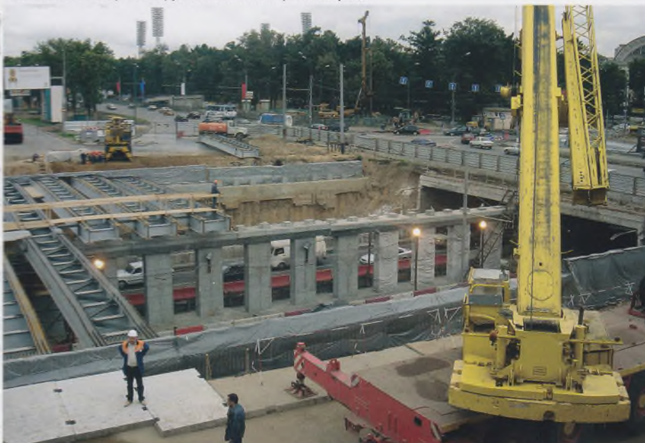
Рис. 6. Работы по реконструкции тоннеля первой очереди
