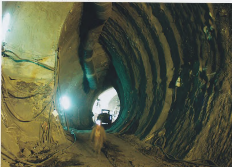
Рис. 4. Пилот-тоннель на временной крепи
