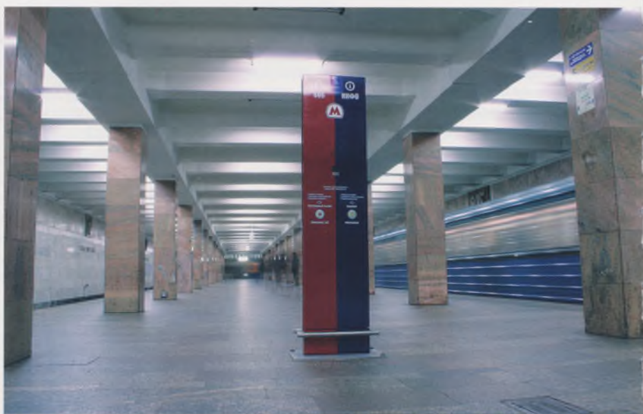
Колонна экстренного вызова на станции «Улица 1905 года»
