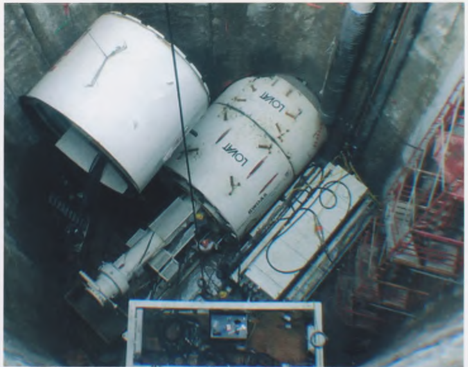
Рис. 7. Запуск проходческого комплекса на участке 2
