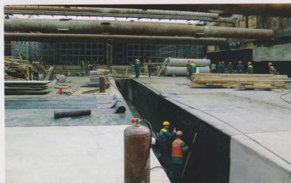
Рис. 8. Выполнение работ по гидроизоляции
