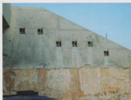
Рис. 4. Испытания пробного анкера из трубчатых винтовых штанг при строительстве Серебряноборского тоннеля
