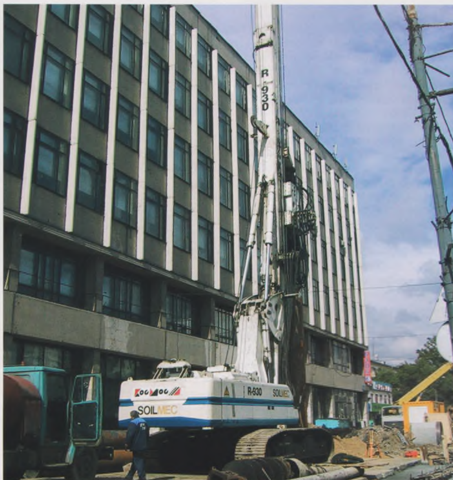
Рис. 10. Выполнение работ по устройству ограждающей конструкции в стесненных условиях
