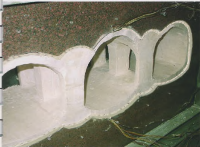
Рис. 3. Проходка среднего станционного тоннеля
