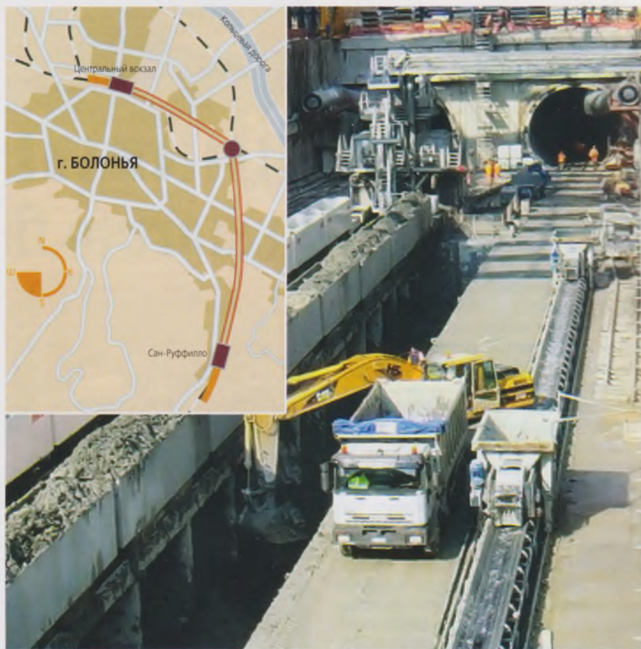
Рис. 1. На схеме Болонского транспортного узла (Nodo di Bologna) показано расположение двойного тоннеля от Сан-Руффилло до Центрального вокзала. На фотографии — южный портал в Сан-Руффилло, где производилось техническое обслуживание и запуск двух одинаковых проходческих комплексов с компенсацией давления горных пород для проходки тоннелей внутренним диаметром 8,3 м и длиной 6,1 км
