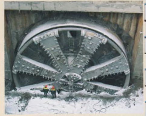
Щит, с помощью которого пройдены тоннели под Эльбой, Лефортовский и Серебряноборские, возможно будет сооружать и Орловский тоннель
