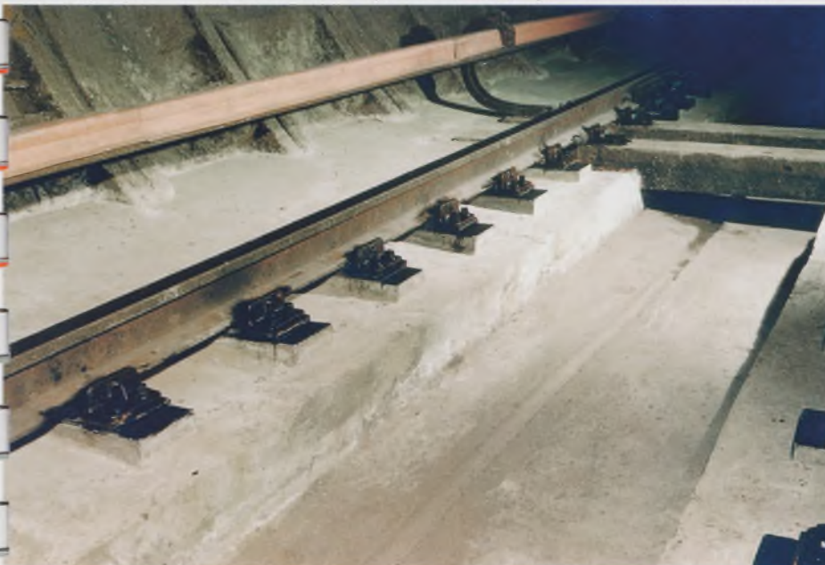
Рис. 5. Опоры, установленные в тоннеле на перегоне «Площадь Мужества» – «Академическая»
