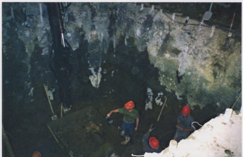
Рис. 8. Завершение работ по проходке подземной камеры, проводимой ниже уровня грунтовых вод
