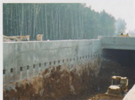
Рис. 5. Применение анкерных свай для крепления подпорных стенок путепровода тоннельного типа в районе съезда № 8 при реконструкции Киевского шоссе
