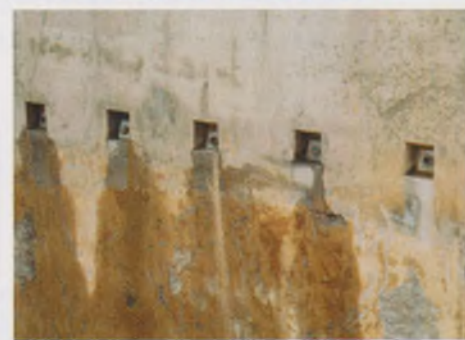
Рис. 5. Применение анкерных свай для крепления подпорных стенок путепровода тоннельного типа в районе съезда № 8 при реконструкции Киевского шоссе
