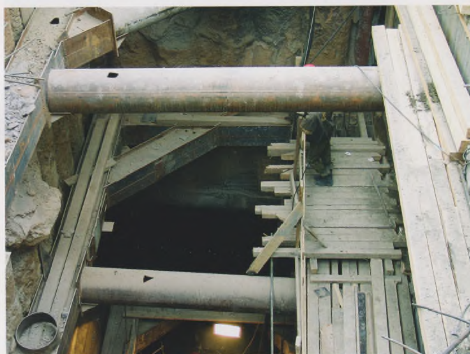
Рис. 7. Притоннельное сооружение. Возведение постоянных конструкций
