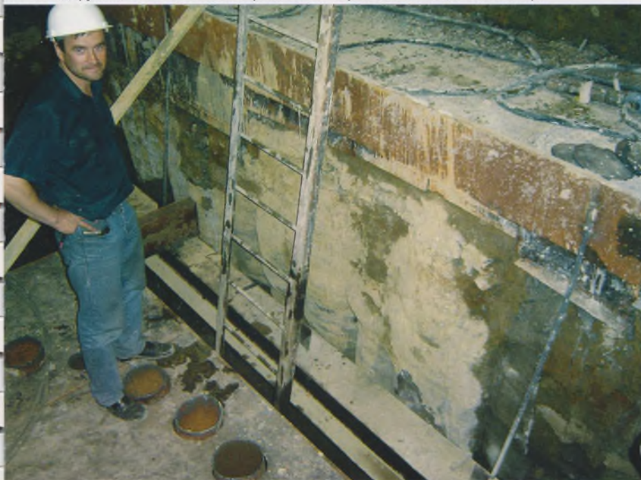
Рис. 2. Вид грунтоцементных свай на первом этапе – строительстве подземной камеры
