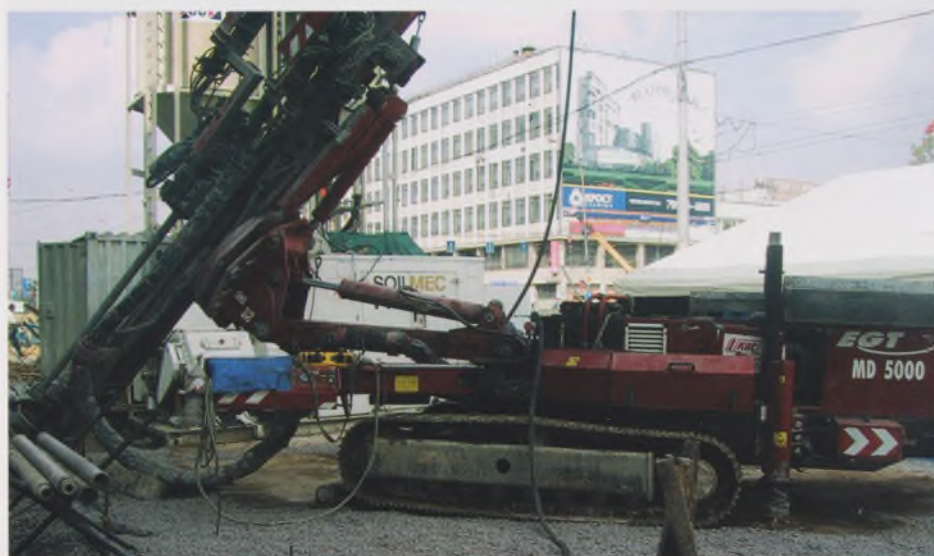
Рис. 5. Укрепление фундамента здания, выполняемое по манжетно-пакерной технологии
