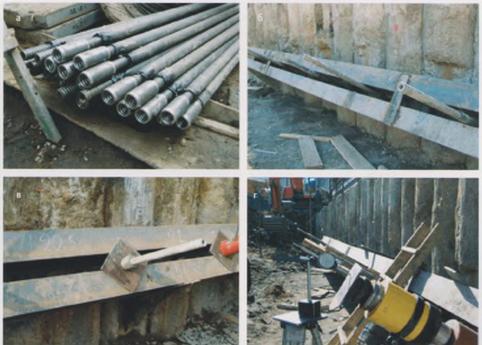
Рис. 3. Применение трубчатых винтовых штанг при строительстве вестибюля второго выхода станции «Маяковская»: а – трубчатые винтовые штанги с навинченной соединительной муфтой и установленной пластиковой трубкой; б, в – анкеры из ТВШ, установленные на ограждающей конструкции; г – статические испытания
