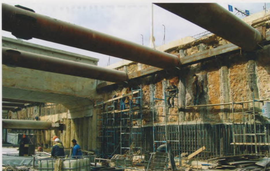
Рис. 3. Ограждающая конструкция котлована
