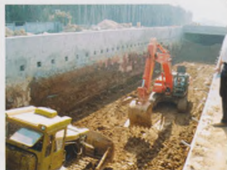
Рис. 4. Испытания пробного анкера из трубчатых винтовых штанг при строительстве Серебряноборского тоннеля
