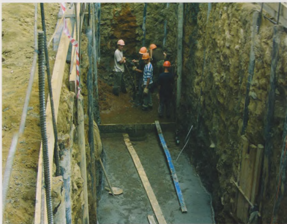
Рис. 4. Невьюра, выполненная методом струйной цементации
