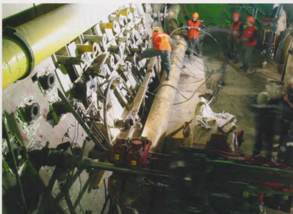
Работы по укреплению грунтов на 2-й сбойке по технологии «Микродур»
