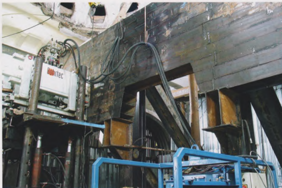
Буровая машина ВМ-400 и упорная стенка
