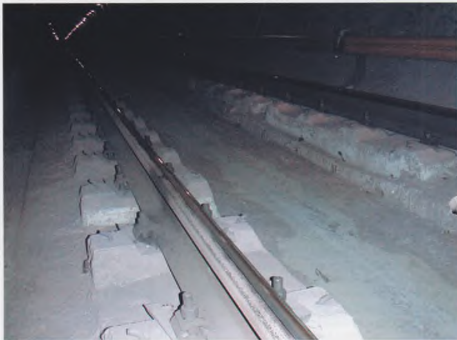
Рис. 1. Конструкция пути с лежнями, замоноличенными в бетон
