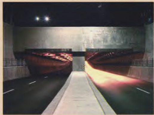
Тоннель Этуотер после полной реконструкции, эффективно освещенный системой ITL™
