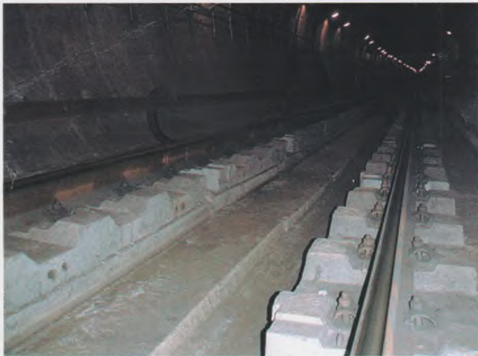
Рис. 2. Лежневое основание в монолитном исполнении
