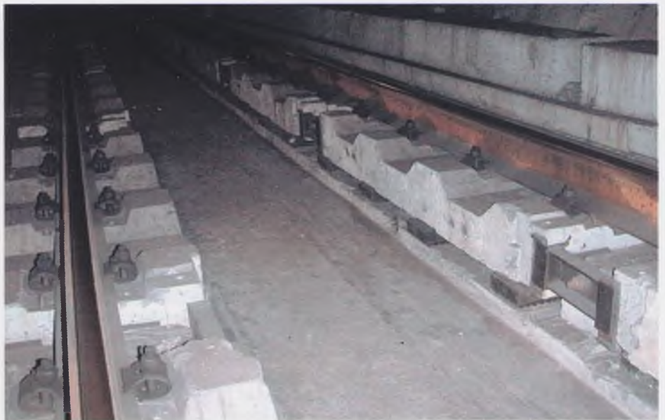
Рис. 3. Лежневое основание в виброзащитном исполнении
