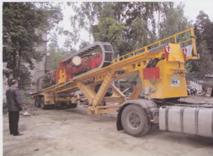
Установка горизонтально-направленного бурения НК-250 S фирмы «Херренкнехт»
