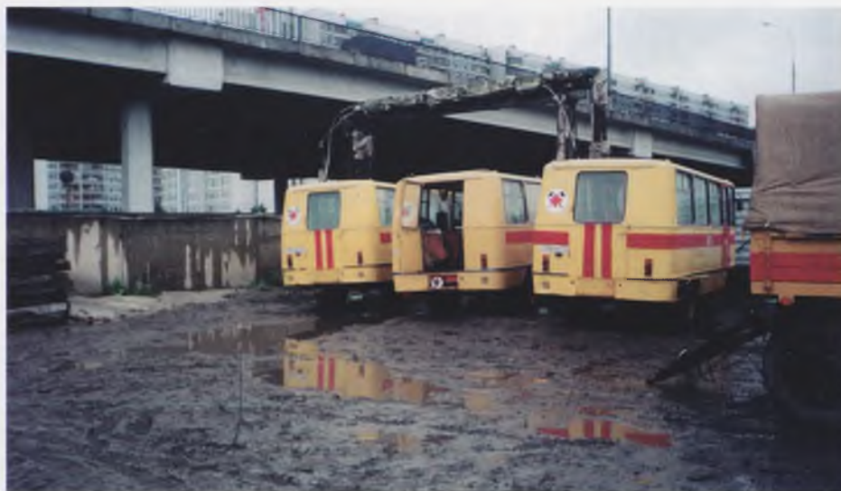
Горноспасательный взвод на строительной площадке объекта по аварийному вызову
