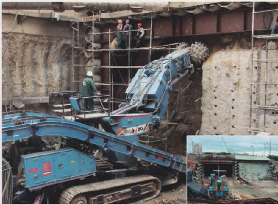
Рис. 5. Разработка грунта проходческим комбайном «Alpine Westfalia» фирмы «Tamrock»
