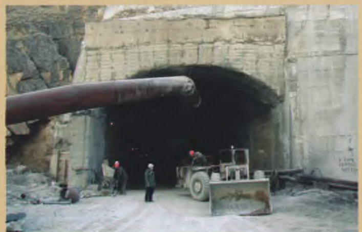
Низовой портал тоннеля
