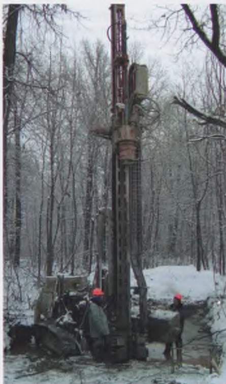
Рис. 2. Производство работ на площадке
