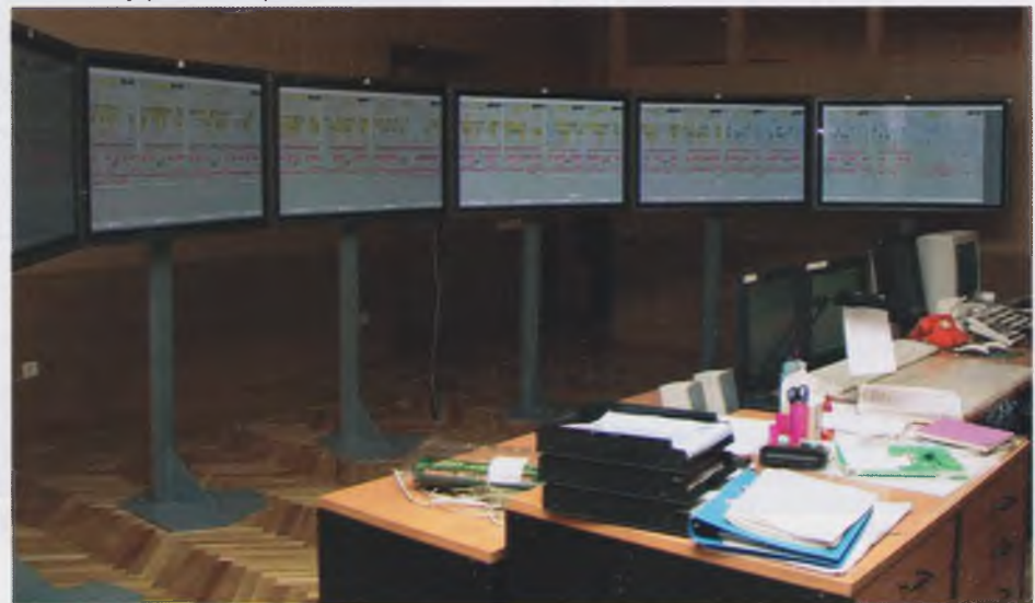
Рис. 3. Посты управления энергоснабжением
