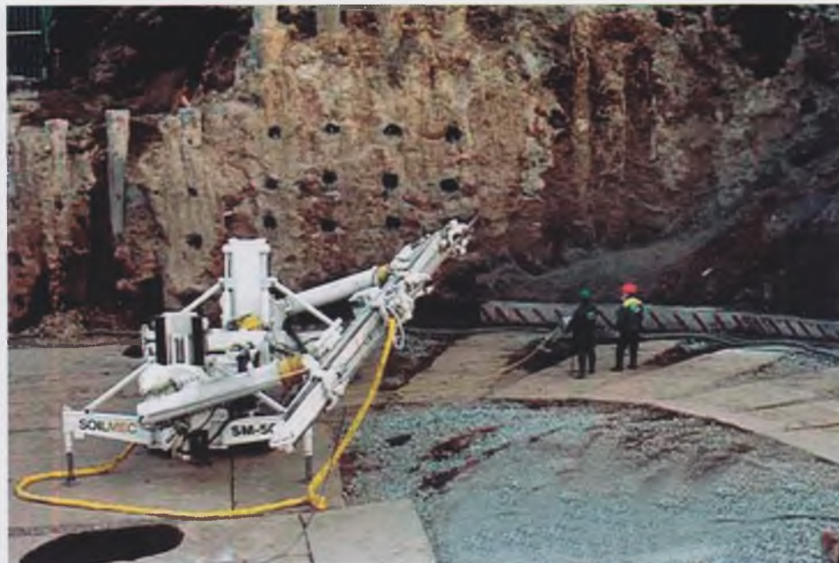
Рис. 3. Бурение горизонтальных грунтоцементных свай с портала
