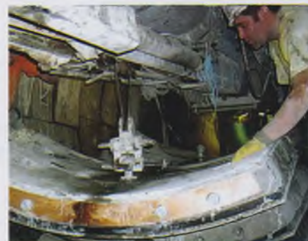
Установка блоков обделки CV Buehan в ходе сооружения тоннеля
