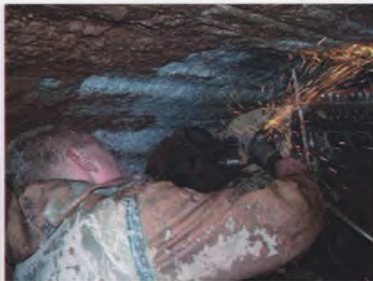
Кессонные работы требуют от человека не только крепкого здоровья, но и соответствующей квалификации. Работы по замене режущего инструмента на роторе ТПМК на проходке Лефортовского тоннеля в Москве
