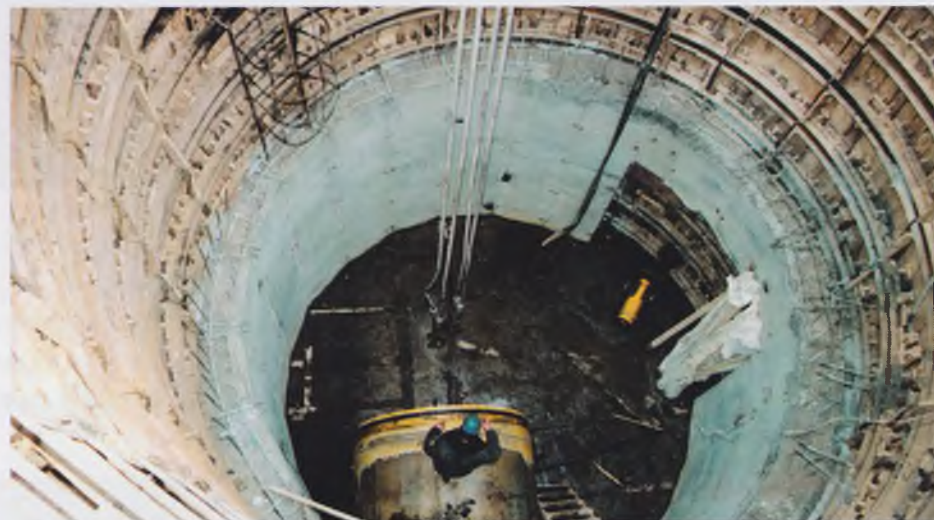
Выход микрощита диаметром 2 м в демонтажную камеру
