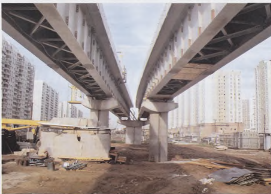
Эстакадный участок представляет собой двухпутный многопролетный мост
