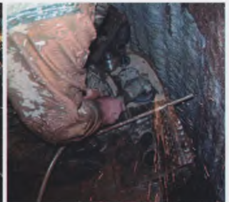
Кессонные работы требуют от человека не только крепкого здоровья, но и соответствующей квалификации. Работы по замене режущего инструмента на роторе ТПМК на проходке Лефортовского тоннеля в Москве
