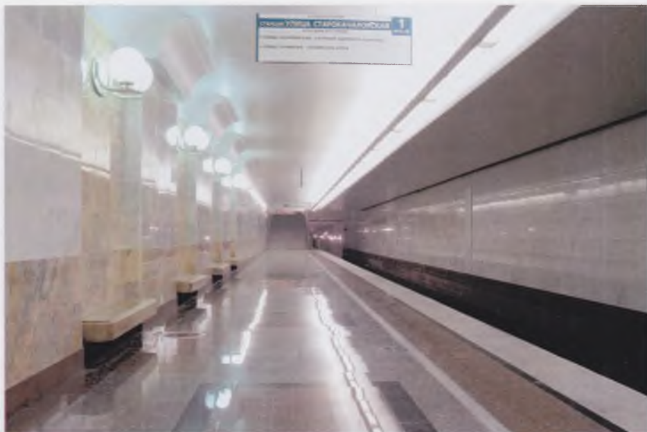
Станция «Улица Старокачаловская» – подземная станция мелкого заложения Бутовской линии
