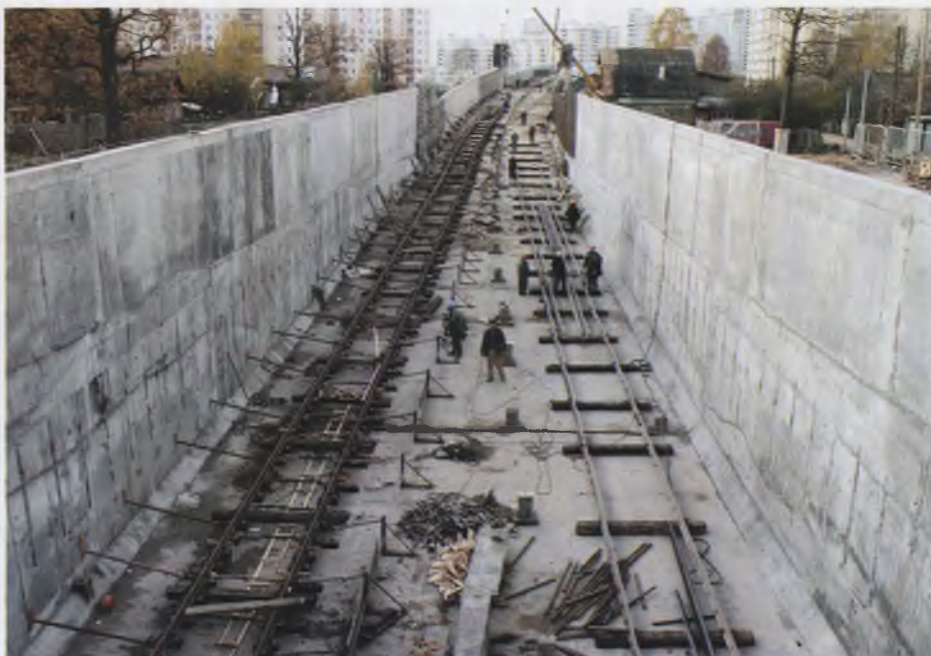
Строительство рампового участка
