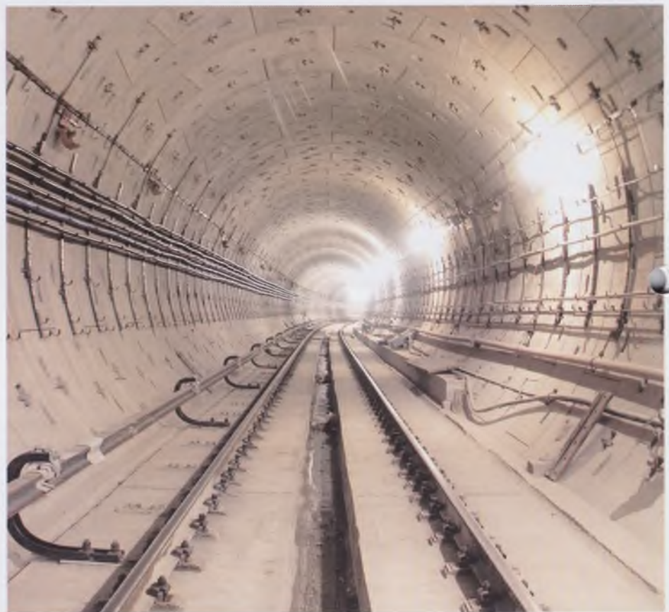
Тоннель, пройденный ТПМК «Ловат»
