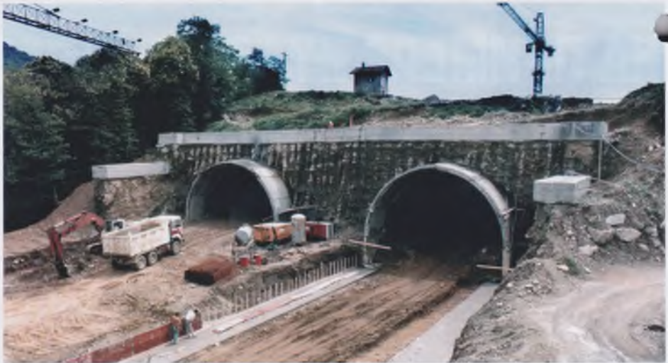
Рис. 3. Вид на северный портал, укрепленный грунтоцементными колоннами, во время строительства автодорожных тоннелей «Malenchini»
