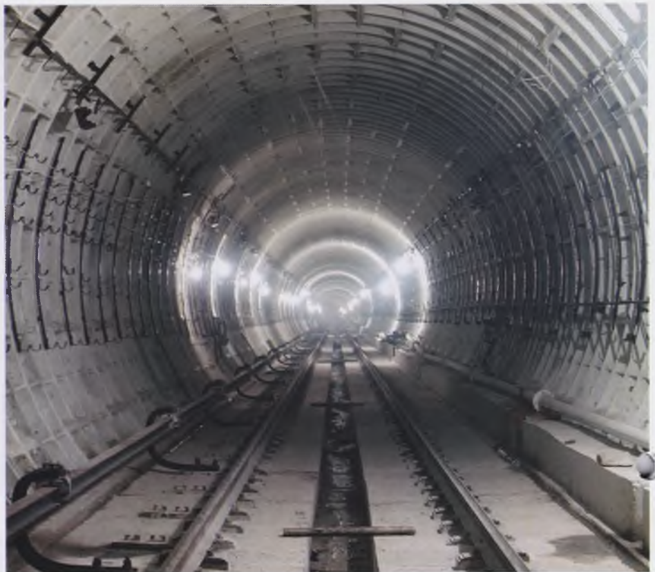
Тоннель, пройденный щитом ЩН-1С
