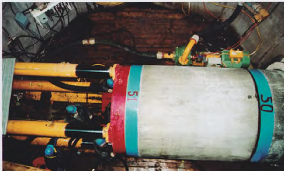
Проталкивание труб
