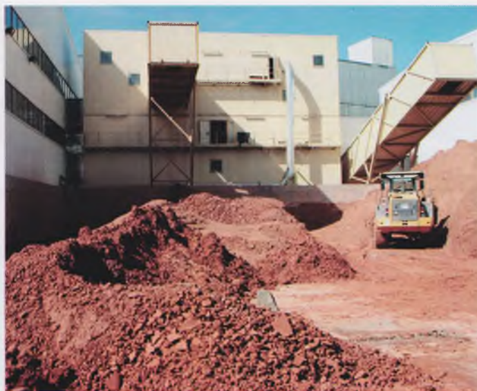
Сепарационная установка, склад сепарированного грунта
