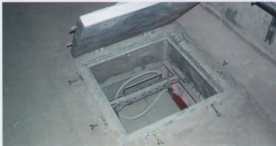
Рис. 6. Противопожарный люк
