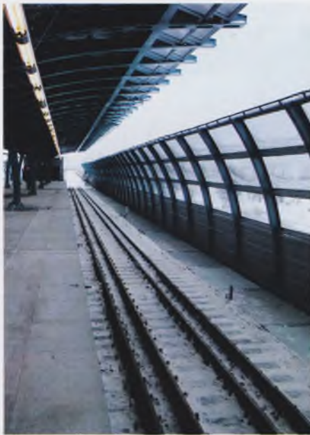
На всем протяжении трассы легкого метро установлены шумоотражающие экраны
