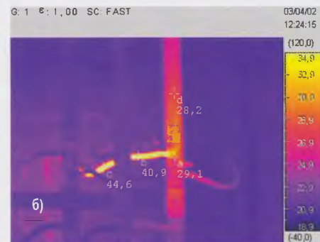
Рис. 8. Ошиновка фазы С щита 220/127 В. Диагностические параметры: (T_a - T_v) – не определялась; K_d = 2,3 . Решение по ТО и Р № 3
