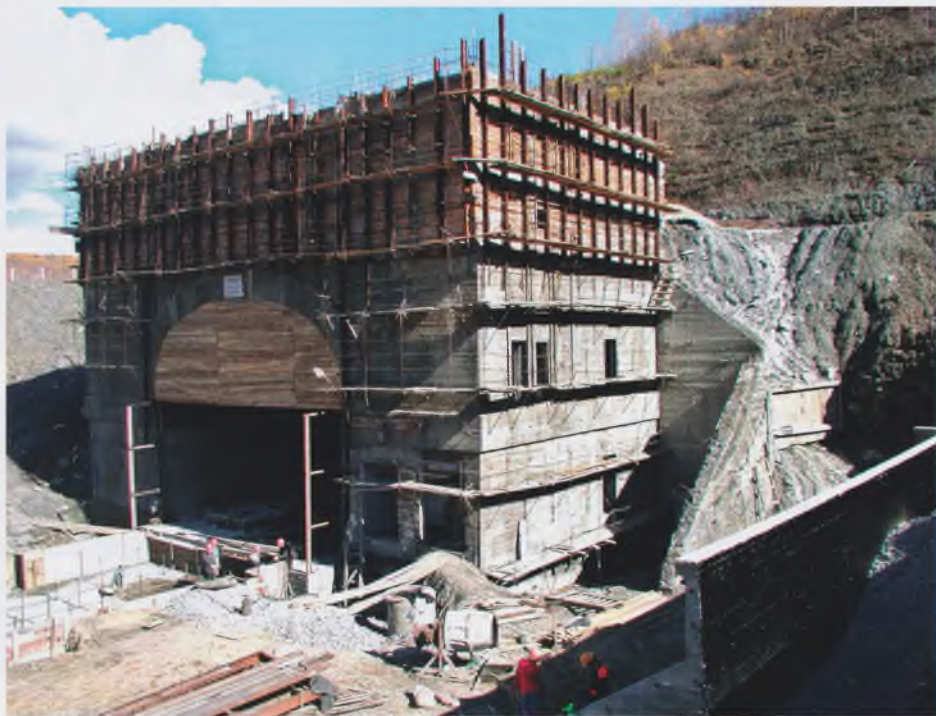
Строительство вентздания со стороны Западного портала
