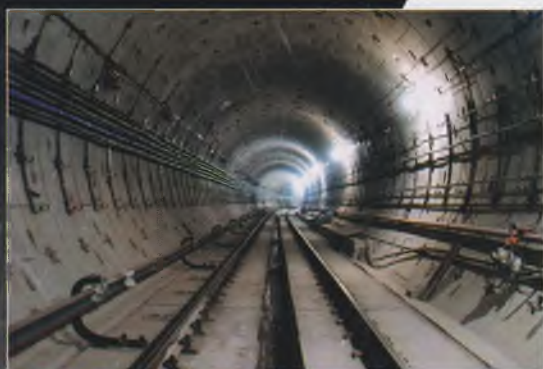
Тоннель Бутовской линии, пройденный ТПМК «Ловат»
