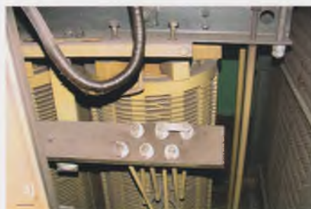
Рис. 9. Трансформатор освещения ТП ТО 1 (6 кВ/220/127 В): а – видеоизображение; б – тепловизионное изображение и результаты его компьютерной обработки
