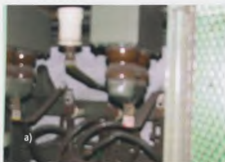
Рис. 4. Кабельный отсек ячейки BB 1 (фаза С): а – видеоизображение; б – ИК – изображение. Диагностические параметры: (T_c - T_v) = 8,6^{\circ}\text{C} ; K_d = 5,0 . Решение по ТО и Р № 1 или 2
