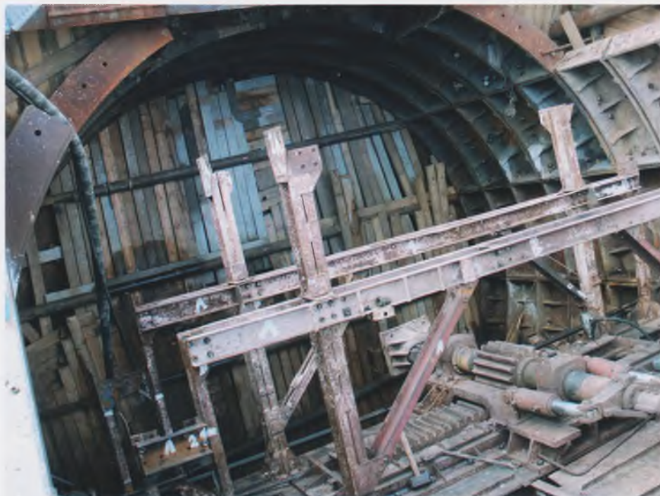
Монтаж тубингоукладчика большого эскалаторного тоннеля
