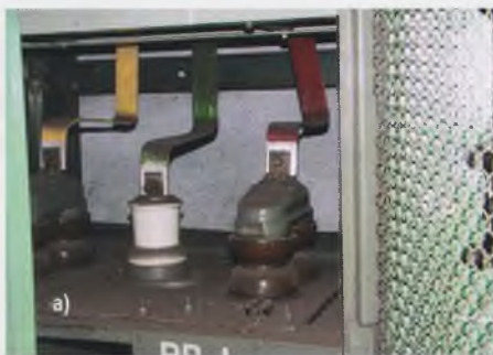
Рис. 3. Ячейка с высоковольтным выключателем (BB1) (фаза С): а – видеоизображение; б – тепловизионное изображение. Диагностические параметры: (T_c - T_a) = 5^{\circ}\text{C} ; K_d = 1,62 . Решение по ТО и Р № 1 или 2
