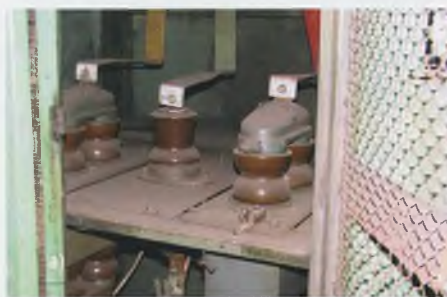
Рис. 6. Проходной изолятор в ячейке ВВ (фаза В): а – видеоизображение; б – ИК – изображение. Диагностические параметры: (T_v - T_b) = 5,2^{\circ}\text{C} ; K_d = 3,1 . Решение по ТО и Р № 1 или 2
