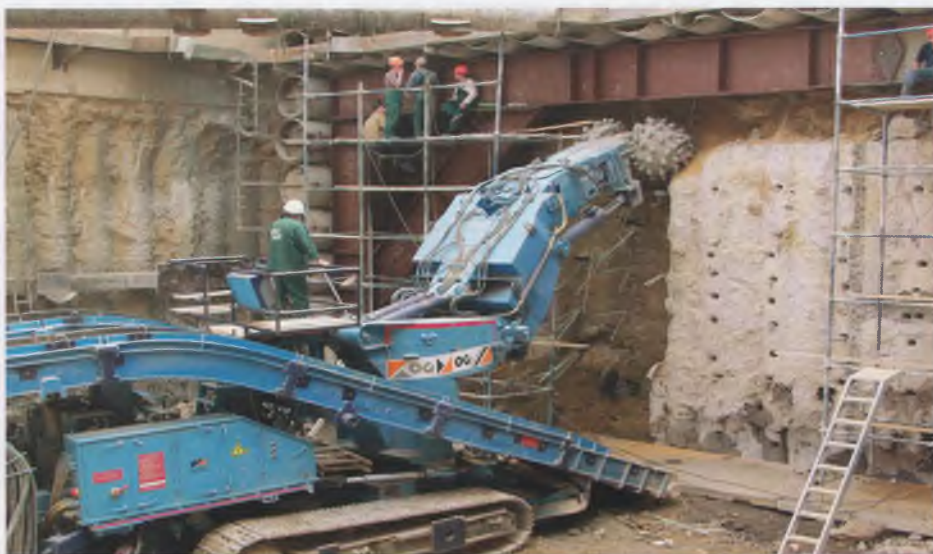
Рис. 8. Выемка укрепленного массива грунта
