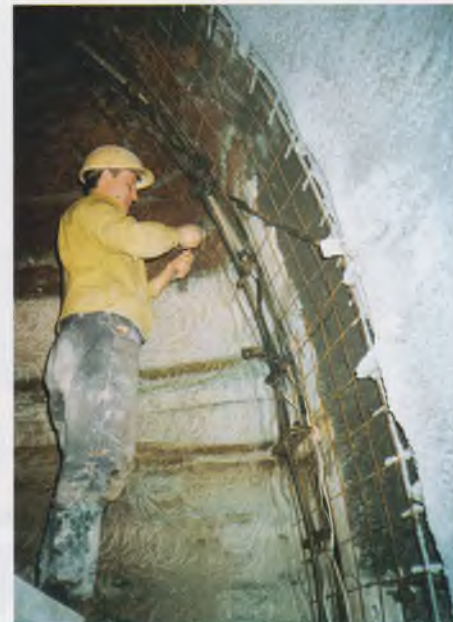
Рис. 3. Установка арки крепи со смонтированными датчиками в проектное положение перед набрызг-бетонированием очередной заходки
