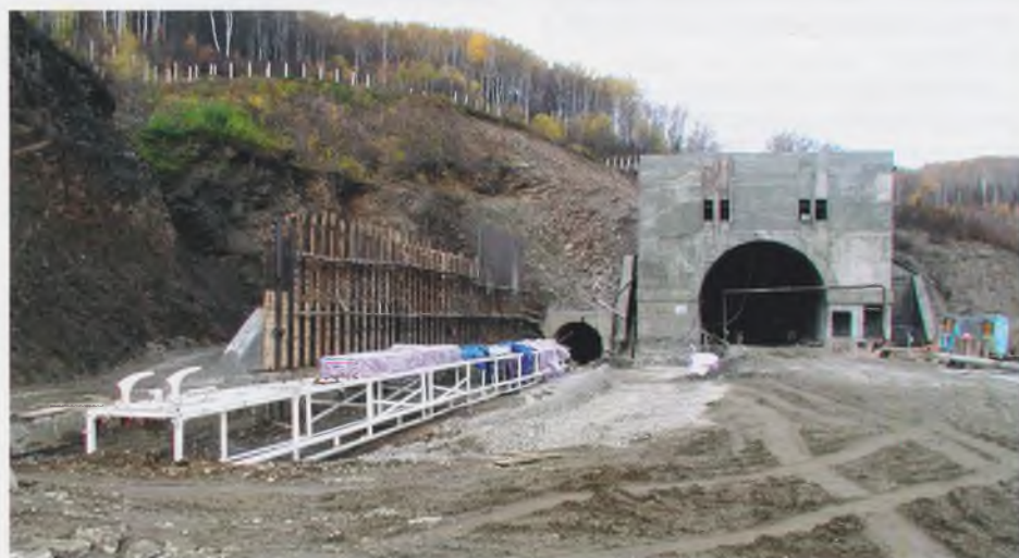
Вентздание со стороны Восточного портала. Монтаж ТПМК «Lovat» RME139SE
