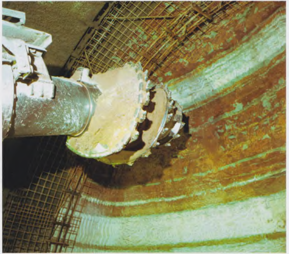
Рис. 1. Рабочий орган проходческого комбайна «Паурат», слева видны арматурные арочные каркасы
