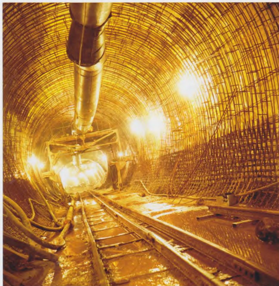
Рис. 2. Монтаж контура гидроизоляции и арматурных каркасов постоянной обделки
