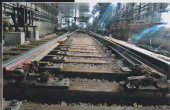
Стрелочный перевод в камере смещения Бутовской линии
