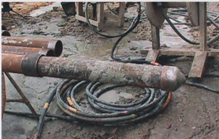
Рис. 6. Наконечник первой секции манжетной трубы
