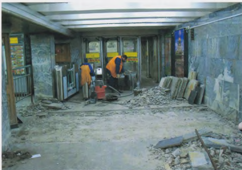
Рис. 1. Разборка покрытия пола и гидроизоляции
