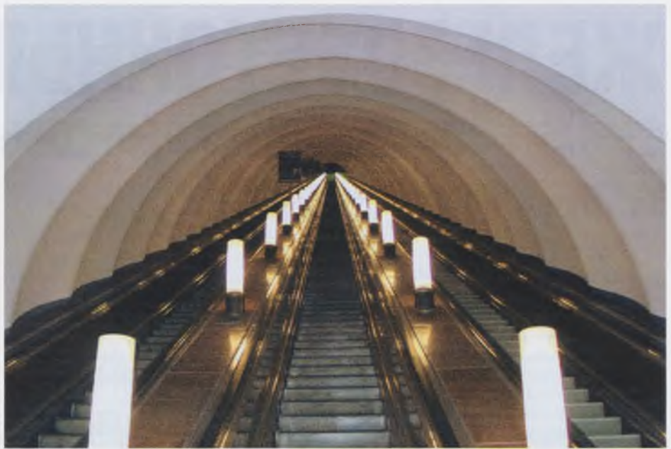
Рис. 9. Свод наклонного хода после проведения ремонтных работ
