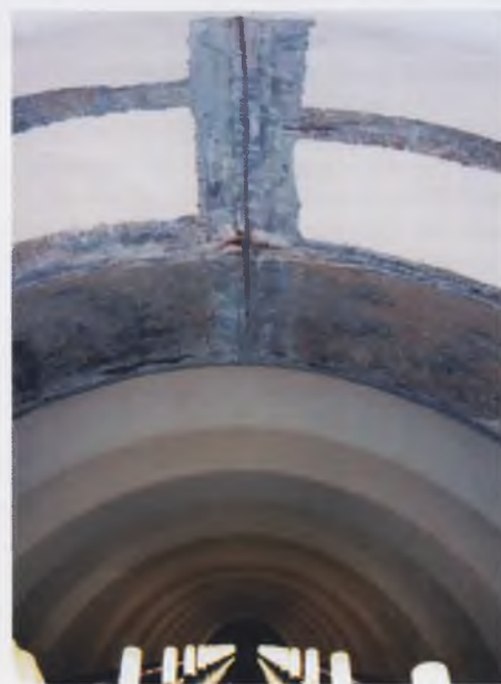
Рис. 7, 8. Ремонтные работы свода наклонного хода
