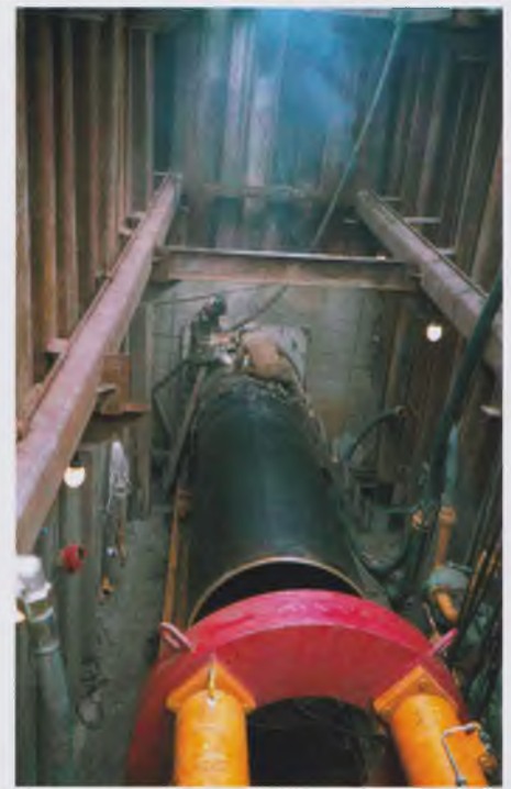
Стартовый котлован дюкера через р. Омь
