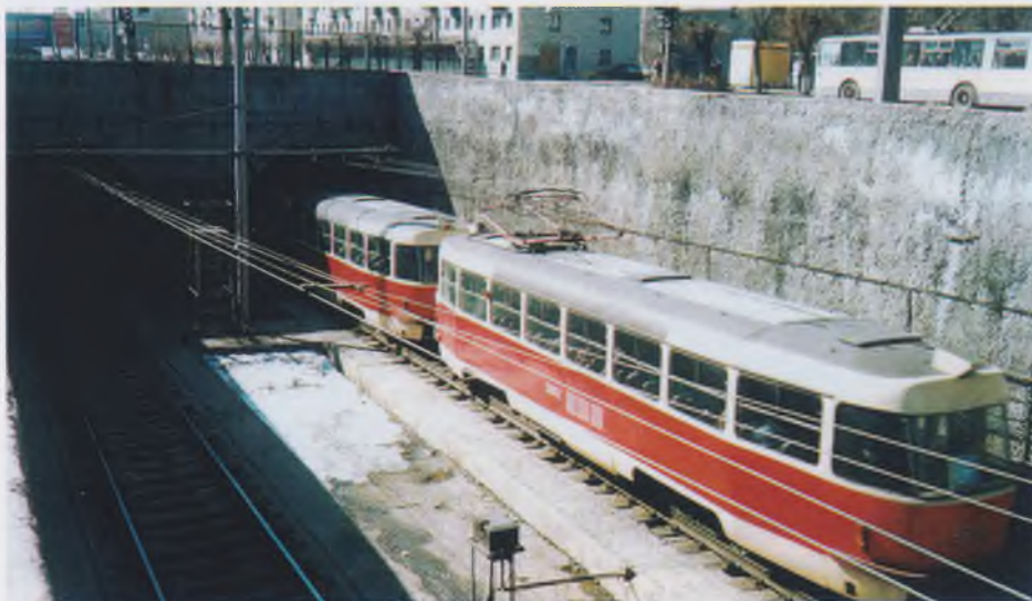
Рамповый участок (въезд в подземный участок)
