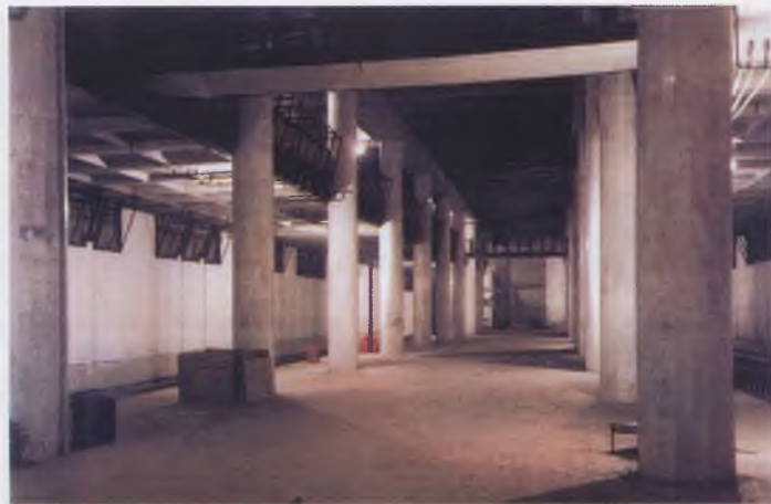
Строительство станции «Профсоюзная»
