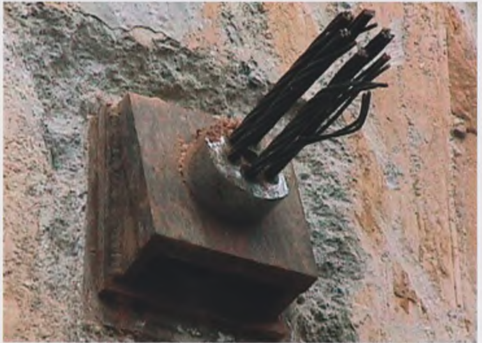
Рис. 8. Анкер закреплен на ограждающей стене
