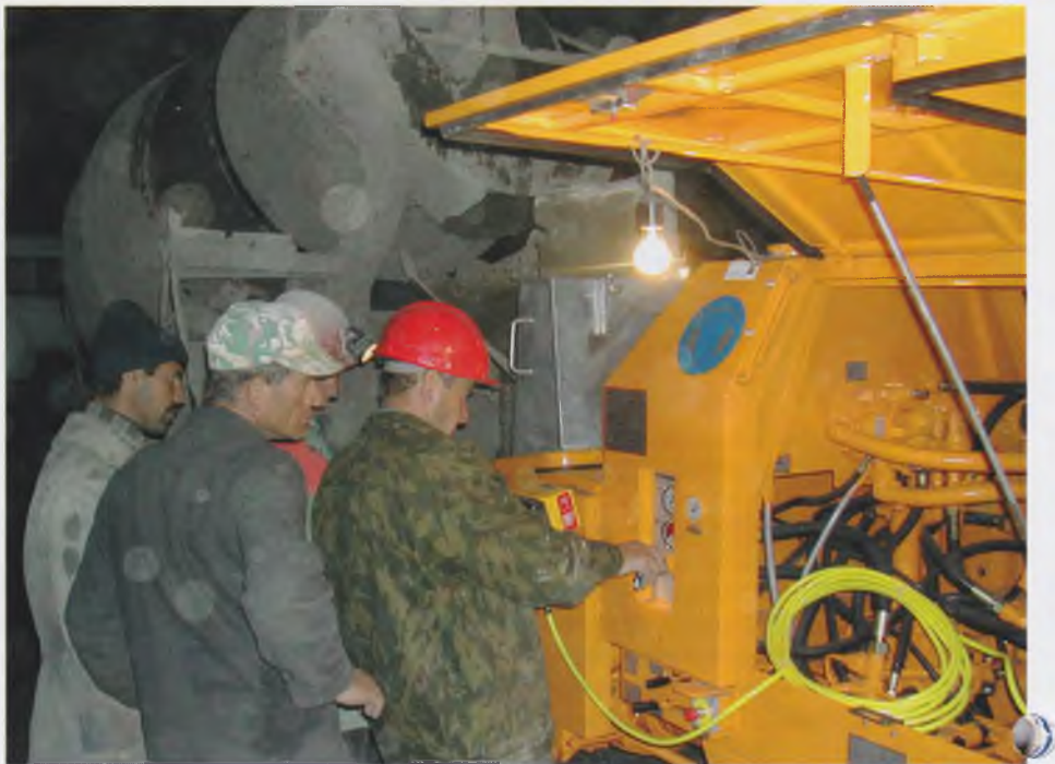
Опытные работы по применению технологии мокрого набрызг-бетонирования установкой фирмы «Путцмайстер»
