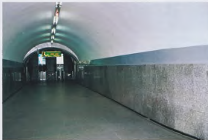
Рис. 5. Подходный коридор после проведения комплекса ремонтных работ
