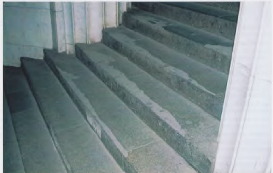
Рис. 10. Отремонтированные ступени лестничного спуска
