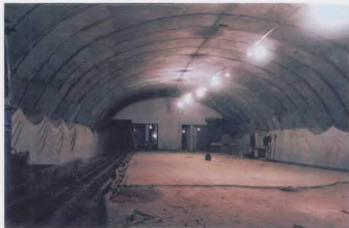
Строительство станции «ТЮЗ»
