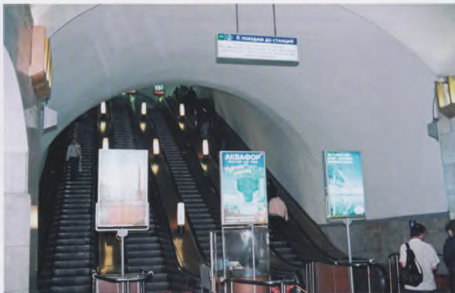
Рис. 6. Свод наклонного хода пересадочного узла
