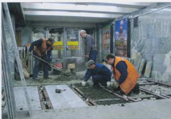
Рис. 3. Устройство гидроизоляции и покрытия пола
