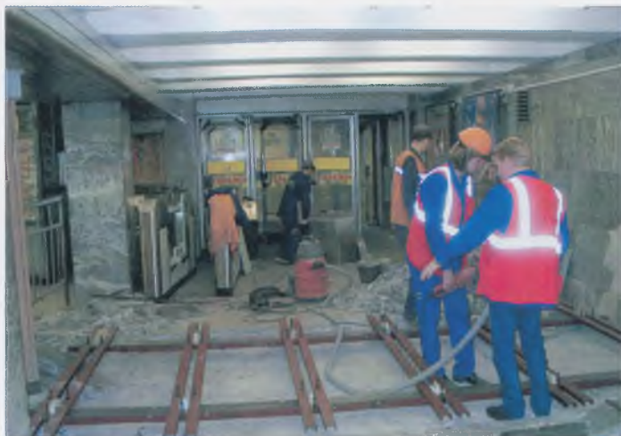
Рис. 2. Монтаж рамы линейки УТ-2000
