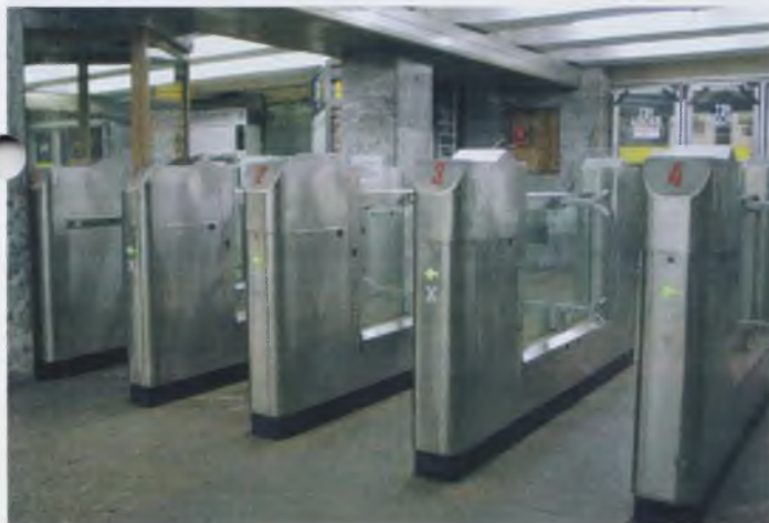
Рис. 4. Монтаж турникетов линейки УТ-2000
