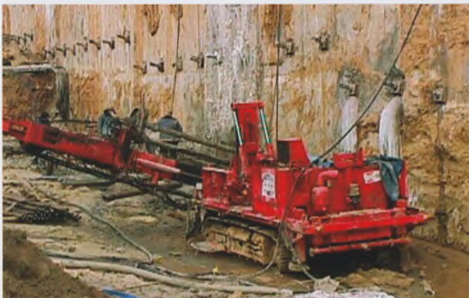
Рис. 3. Буровая установка револьверного типа ДСН 114VB (НВМ-15)
