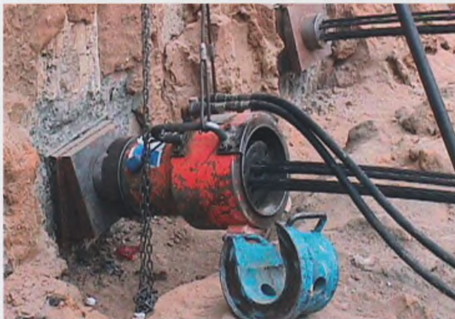
Рис. 7. Домкрат для натяжения анкеров
