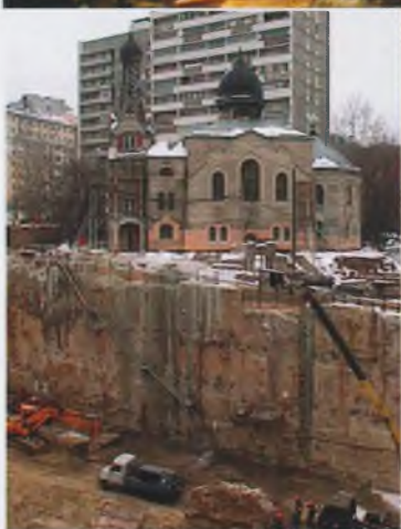
Рис. 1. Общий вид крепления котлована
