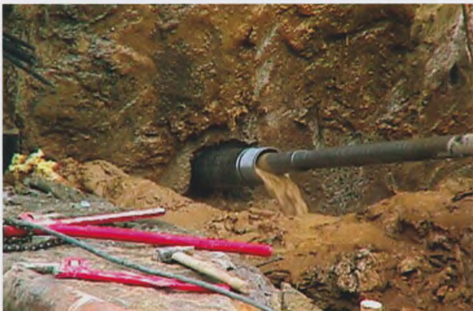
Рис. 4. Бурение скважин под защитой обсадной трубы с промывкой глинистым раствором
