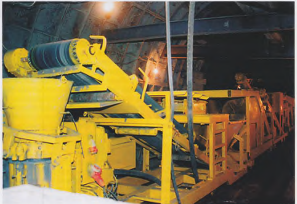
Передвижной комплекс «Алива-Штеттер» для набрызг-бетона временной крепи свода станции
