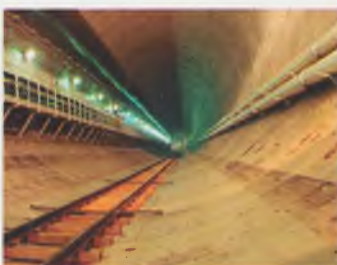
Вид готового участка тоннеля
