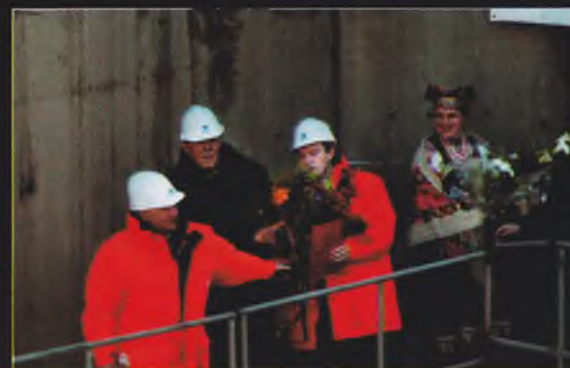
Ю. М. Лужков после осмотра готового тоннеля
