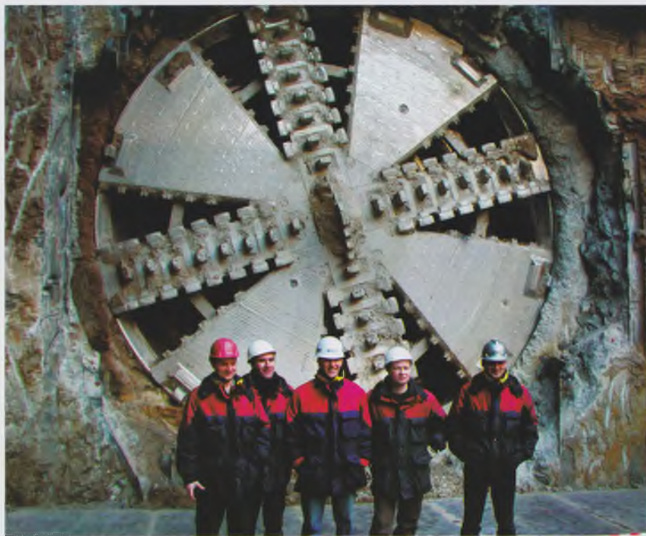
Бригада проходчиков ТО № 6
