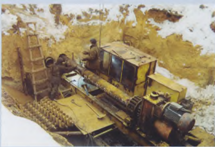
Горизонтальное бурение под железной дорогой (Екатеринбург)
