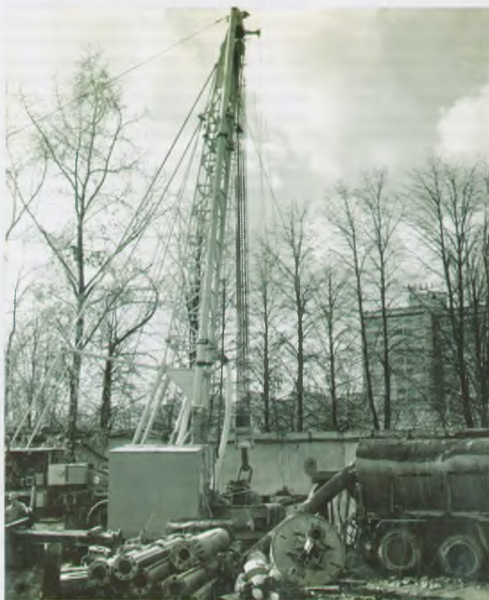
Установка «Wirth» L-4. Бурение скважин большого диаметра на станции «Петровско-Разумовская»
