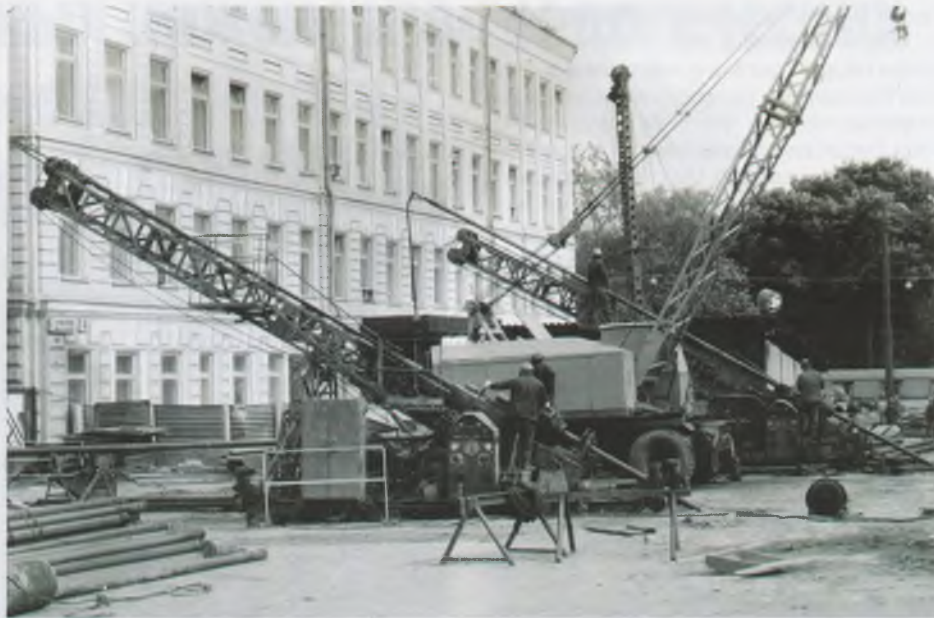
Бурение замораживающих скважин на станции «Чеховская» установками ТУН Б-150
