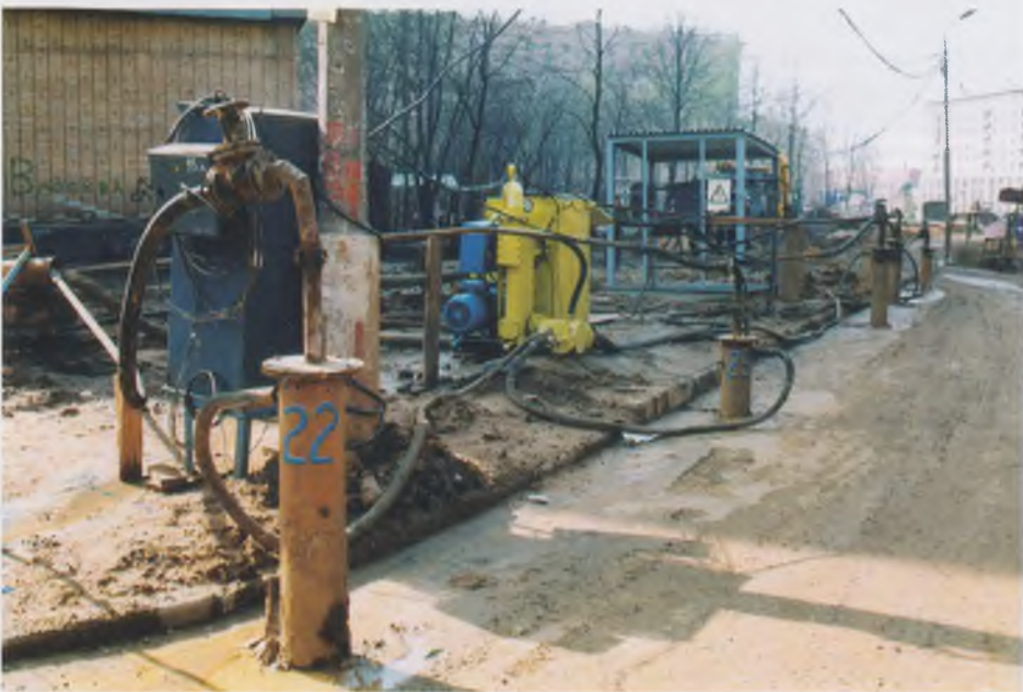
Водопонижение с использованием погружных насосов, подключенных на вакуумирование
