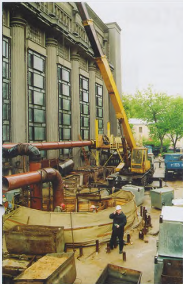
Рис. 10. Сооружение шахтного ствола Т-3 на ул. Большая Никитская с замораживанием грунтов «сухим льдом», работами руководит прораб С. В. Панчев.
