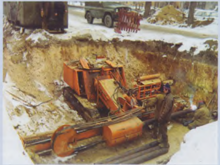
Бестраншейная прокладка коммуникаций методом горизонтального бурения
