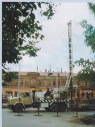
Бурение скважин под буронабивные сваи установкой MAST BUD M-150
