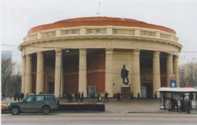
Вестибюль станции метро «Краснопresненская». Закрепление фундаментов выполнено буронабивными сваями ОАО «ВИЗБАС»
