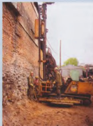
Закрепление стен котлована жилого дома на ул. Белинского
