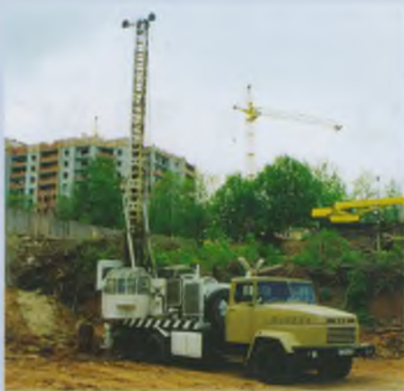
Бурение свай под новое здание
