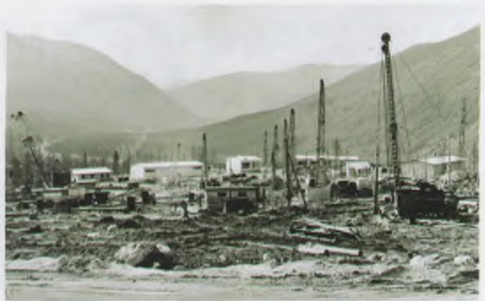
Бурение водопонизительных скважин в зоне размыва при строительстве Северомурaysкого тоннеля, БАМ
