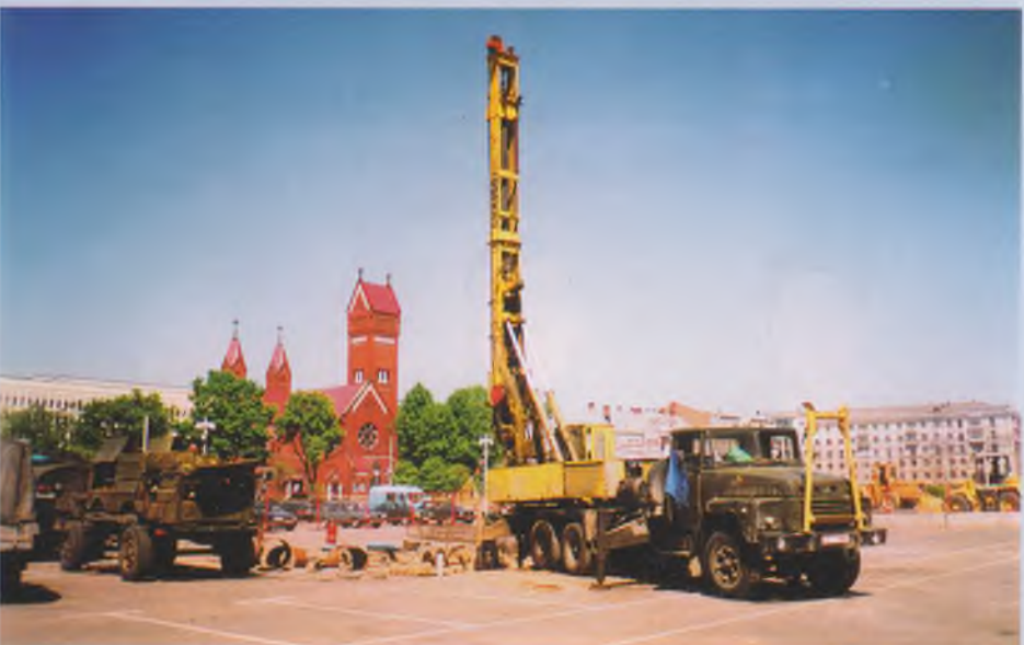
Сооружение буронабивных свай на реконструируемой площади Независимости в г. Минске, май 2002 г.
