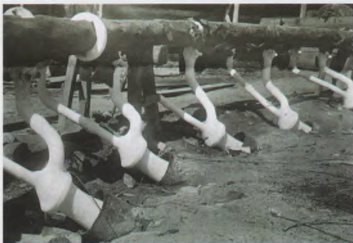
Наклонные замораживающие скважины. Строительство эскалаторного тоннеля станции «Чеховская»
