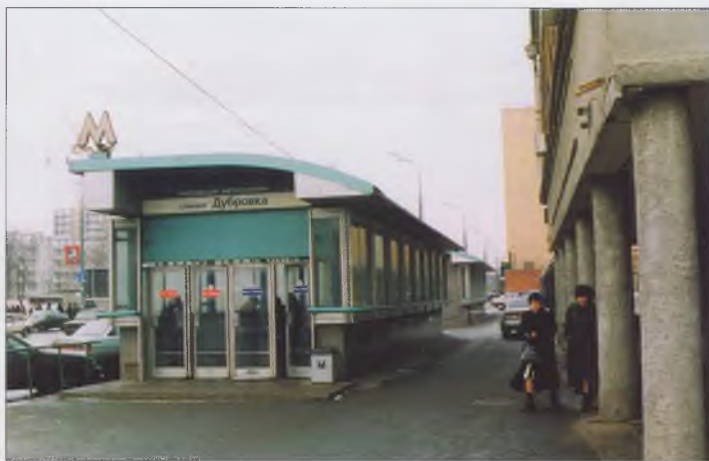
Вестибюль станции «Дубровка» и корпуса шинного завода
