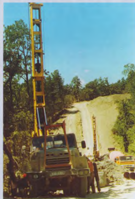
Сооружение свай на строительстве газопровода «Россия – Турция»
