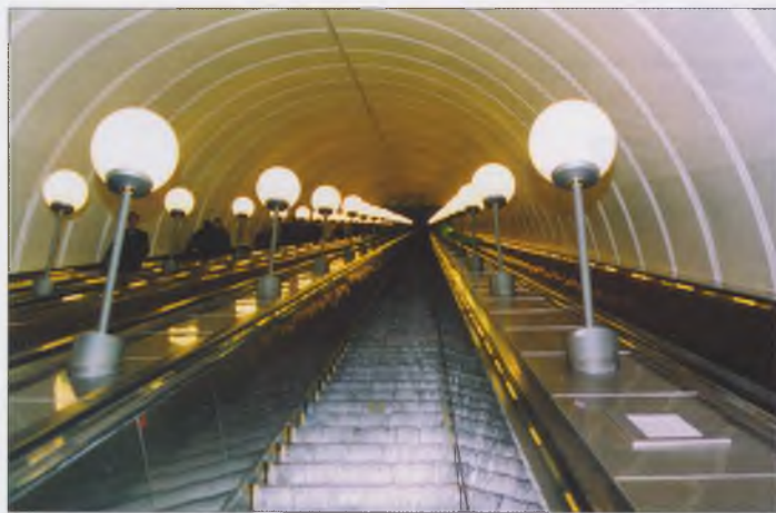
Эскалаторный тоннель станции «Дубровка»
