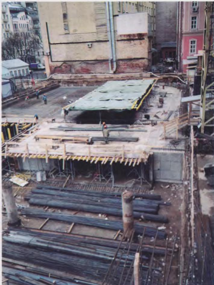
Рис. 6. Возведение первой половины покрытия. Опалубочные и арматурные работы
