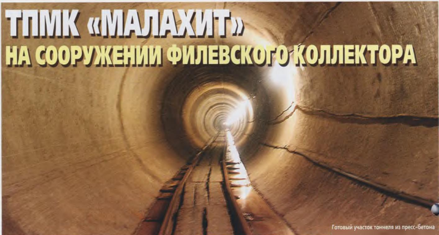
Готовый участок тоннеля из пресс-бетона
