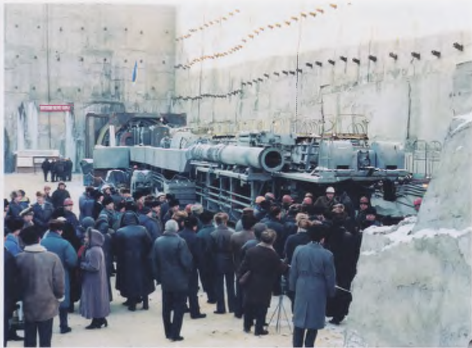
Пуск в работу тоннелепроходческого комплекса КТ-5,6Е-22
