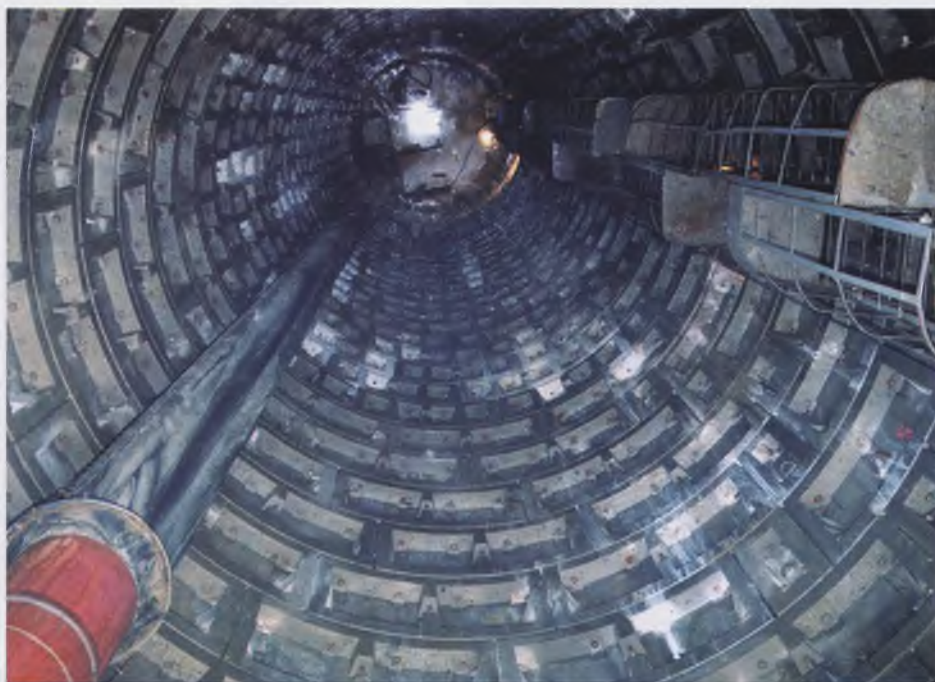
Вертикальный ствол ш. 222 с применением ж/б связевой обделки
