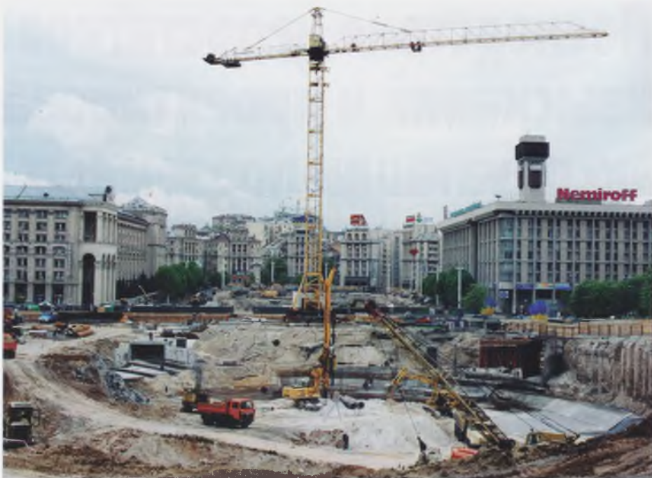
Разработка котлована на площади Независимости
