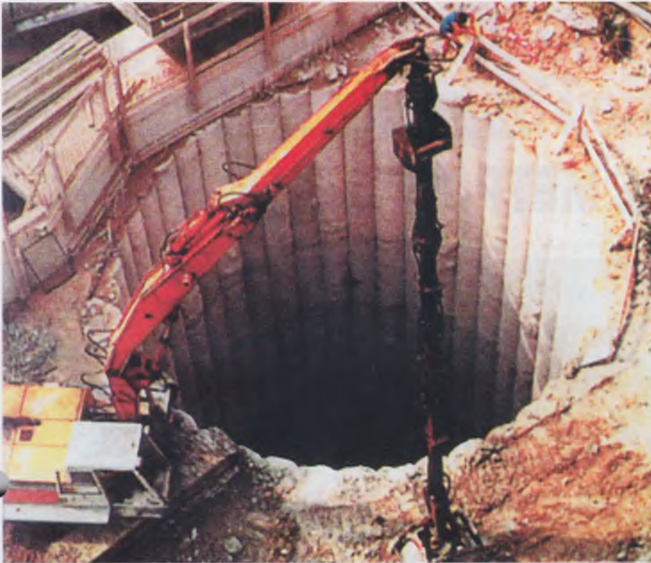
Устье ствола № 220, сооруженного из секущих бетонных (первичных) и железобетонных (вторичных) свай
