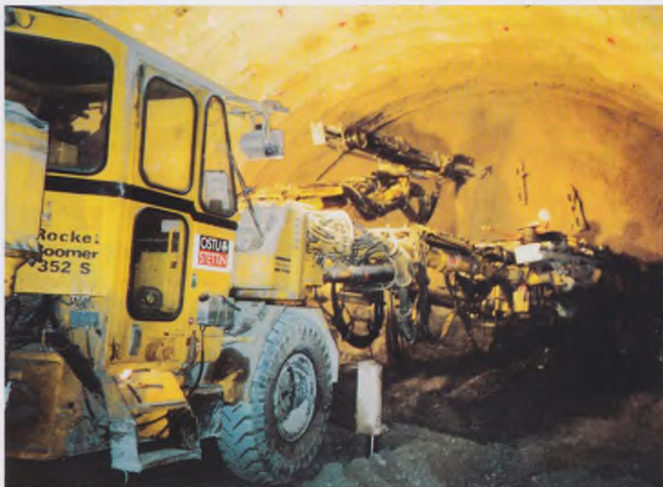
Буровая каретка Atlas Copco Рокет Бумер 352 S при проходке верхней штольни
