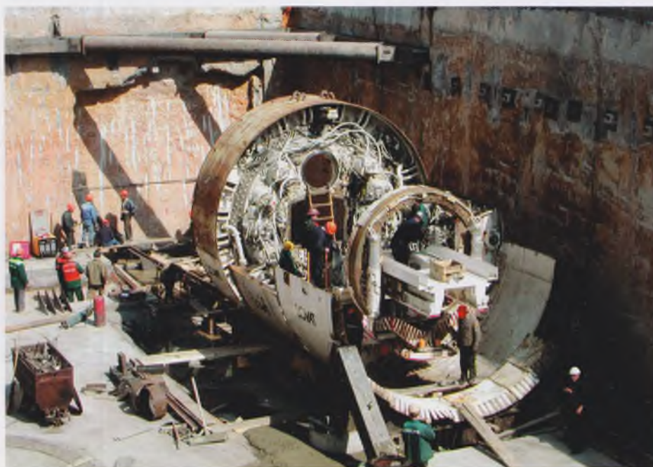
Монтаж ТПК «Lovat» в стартовом котловане
