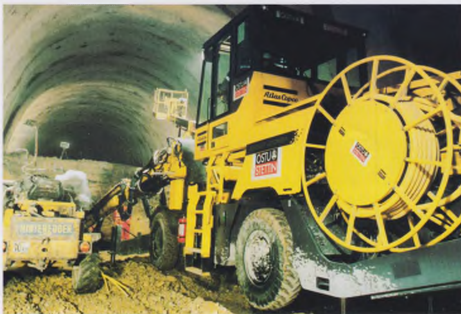
Буровая каретка Atlas Copco Бумер L3C, ведущая работы в южном уступе
