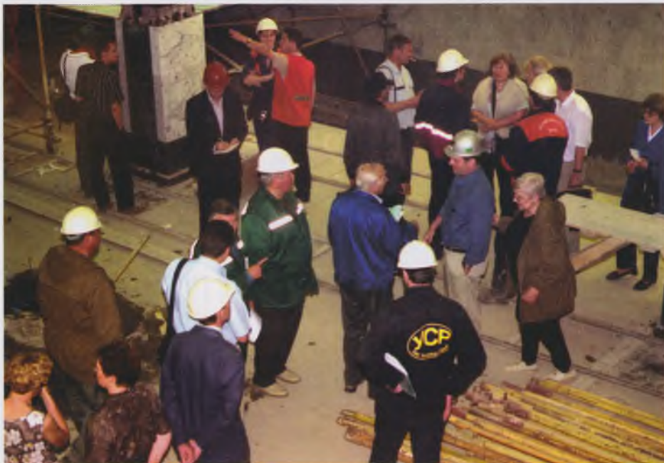
Еженедельный рабочий обход руководством метростроя строительства станции
