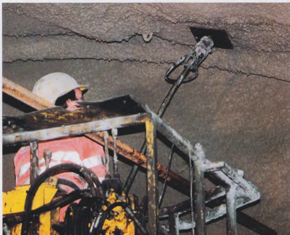
Монтаж анкеров типа «супер-свеллекс», выполняемый из корзинки буровой каретки
