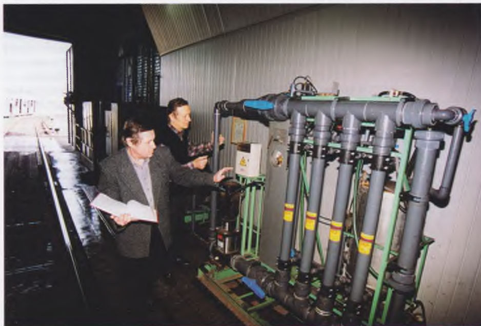
Очистные сооружения электродепо «Дарница»
