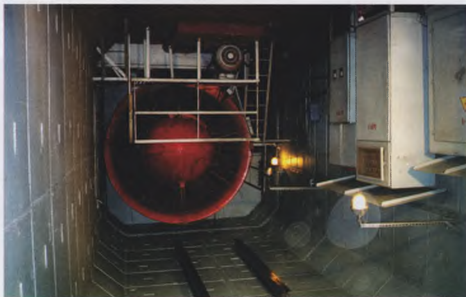
Рис. 1. Реконструируемая вентиляционная шахта
