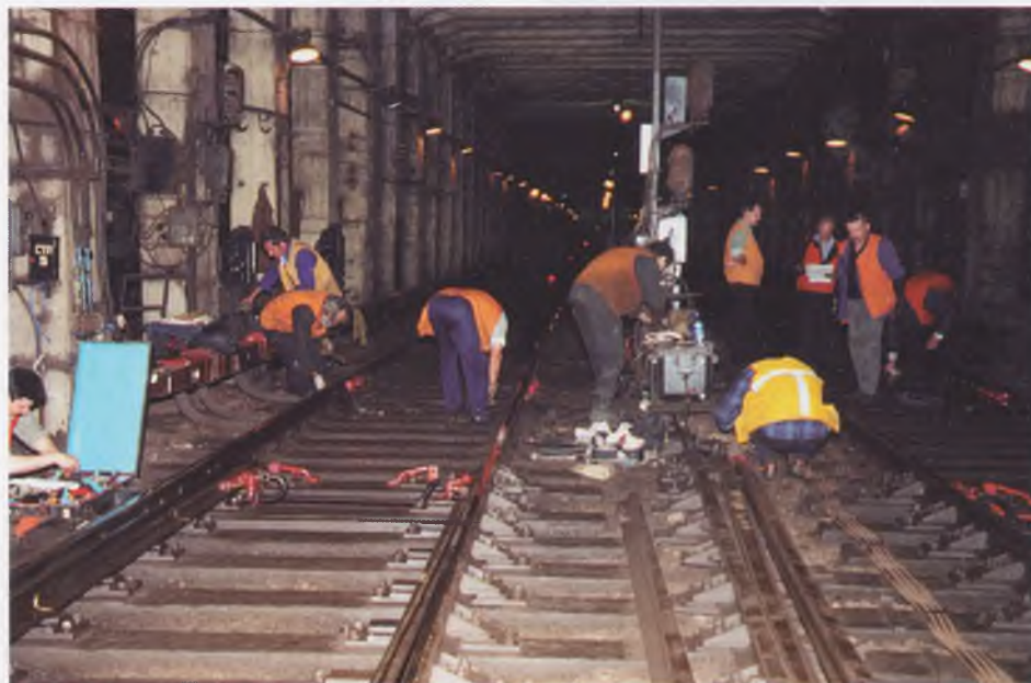
Монтаж нового устройства безопасности на Сокольнической линии
