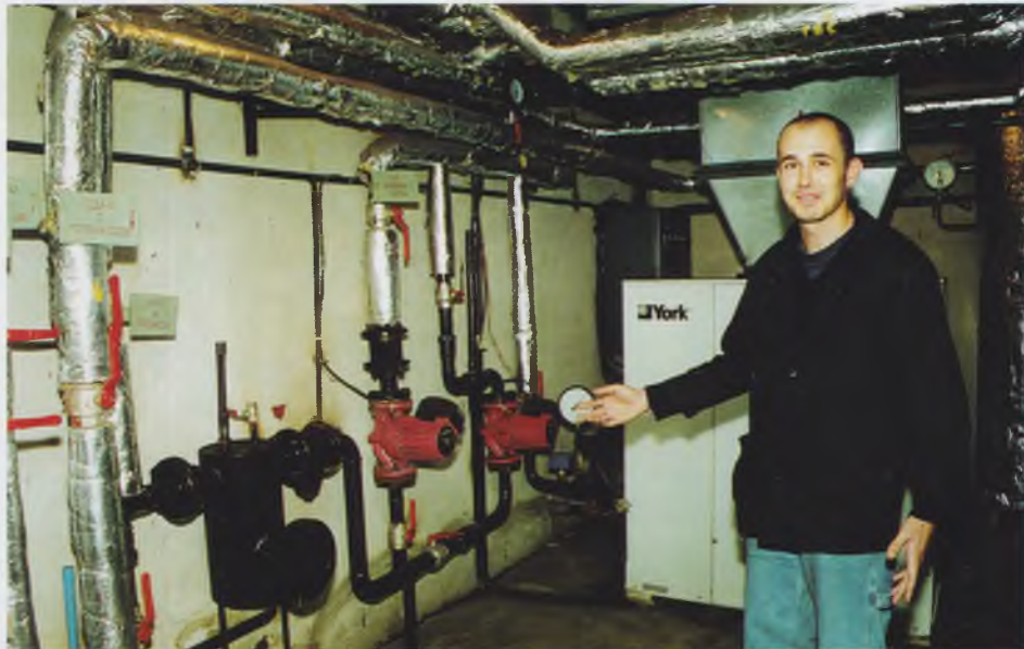
Распредустройства СТП станции «Могилевская»
