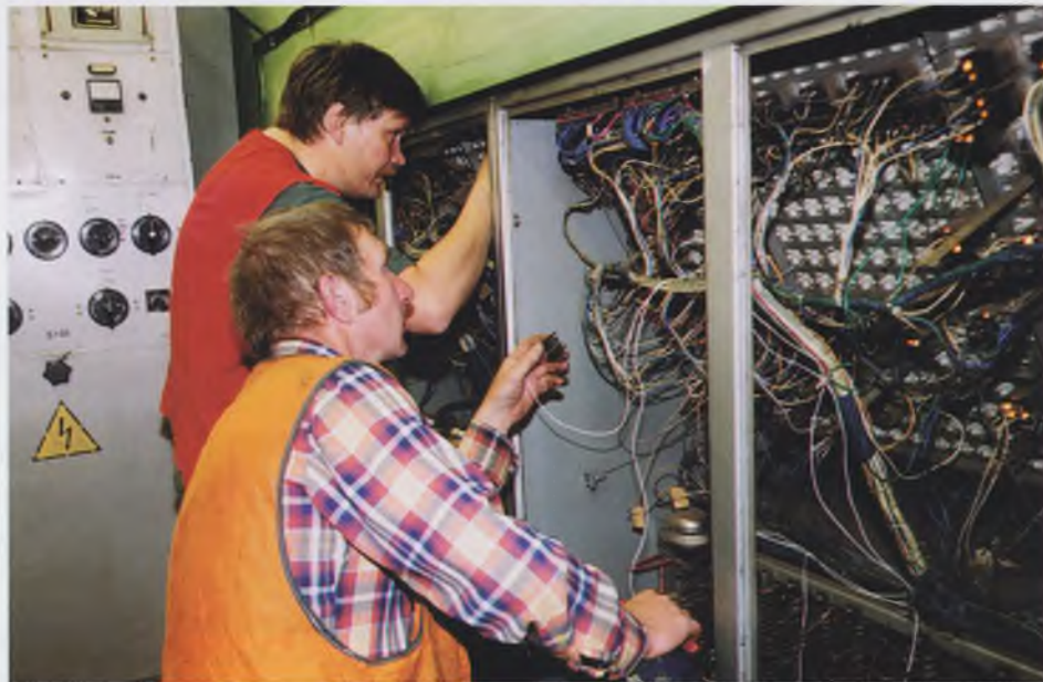
Подключение новых устройств безопасности движения в релейной станции «Улица Подбельского» (Москва)
