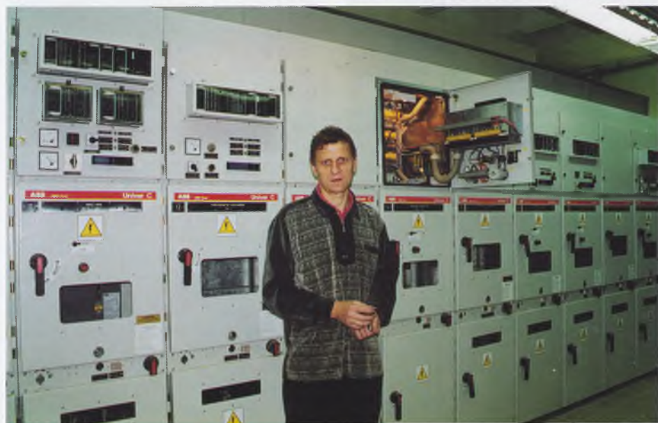
Система автономного теплоснабжения станции «Тракторный Завод»
